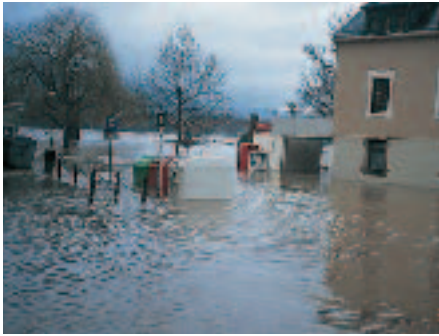
Hochwasseraufbau am Main im Januar 1995
