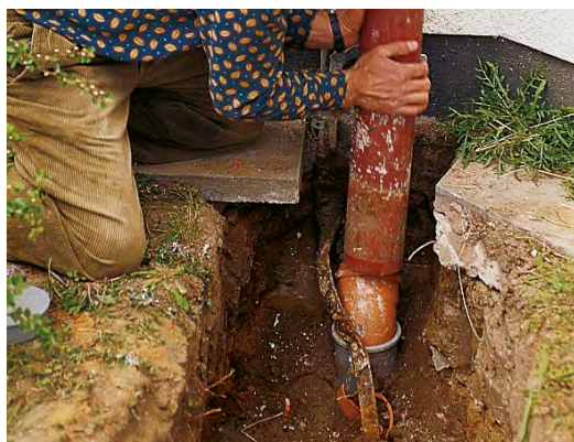
Abb. rechts: Anschluss an Hofablauf.
