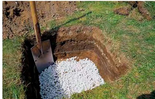
Abb. links oben: Ausheben der Grube.
