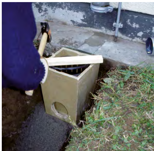
Abb. rechts: Rigolenbereich ausheben.
