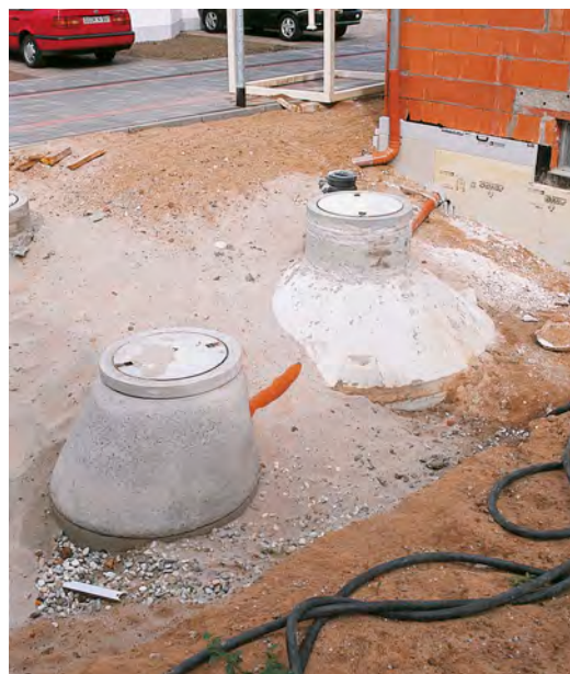
Abb.: Regenwasserspeicher kombiniert mit Versickerung.
