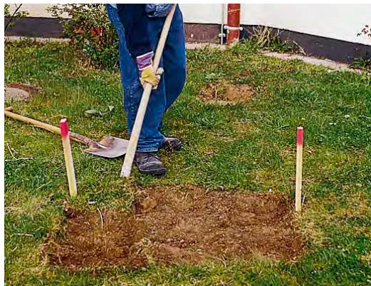
Abb. links: Abstecken der Baugrube.
