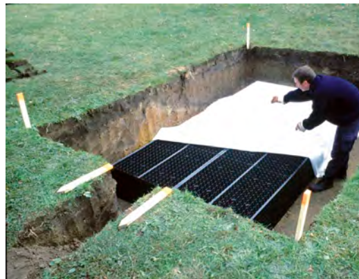
Abb. links: Einsetzen der Kunststoffelemente.
