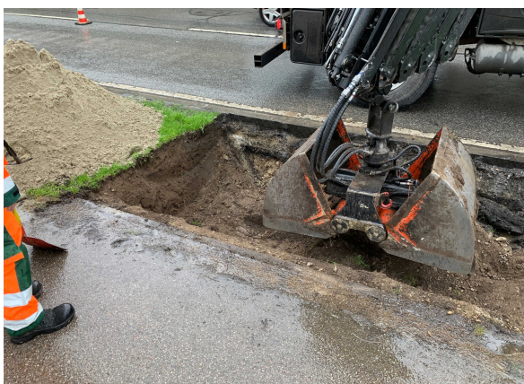
Abb. 8: Aushub für eine straßenbegleitende Versickerungsmulde (im Bestand)
