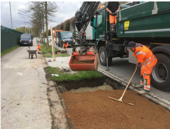
Abb. 10: Einbau der bewachsenen Bodenzone einer Versickerungsmulde.
