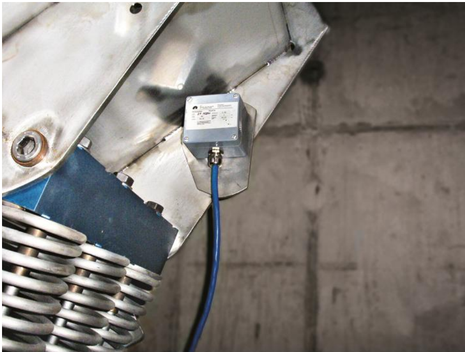
Abb. 24: Winkelgeber an einer Federstauklappe
