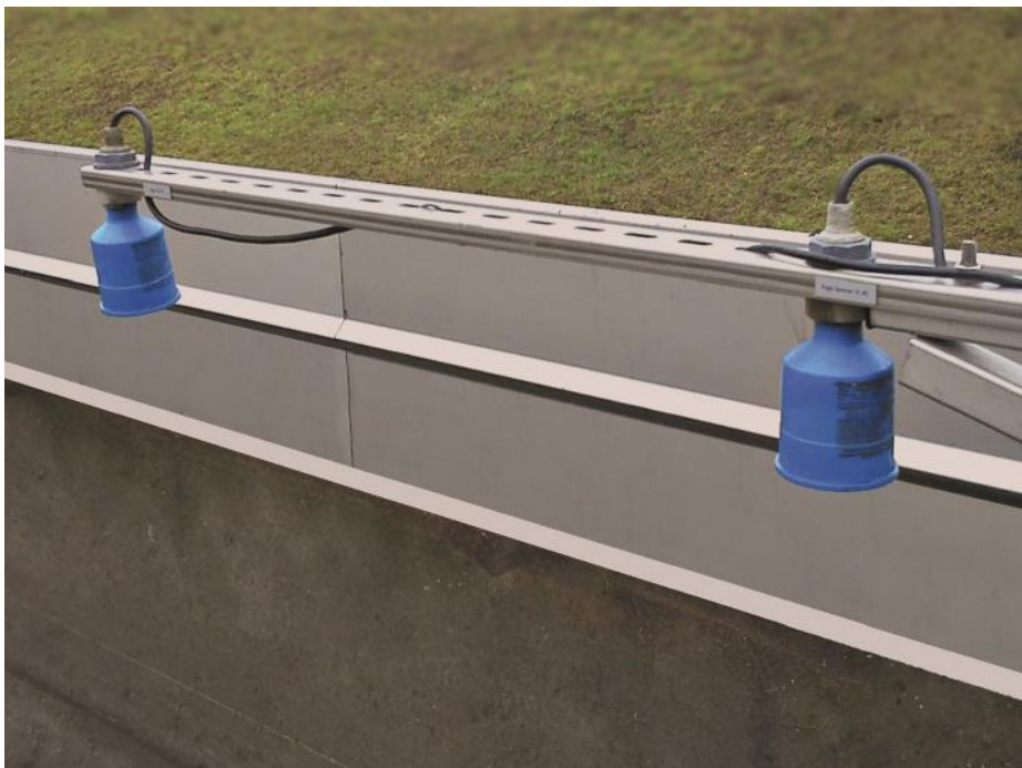
Abb. 26: Ultraschallsonden an einem Regenüberlauf- becken
