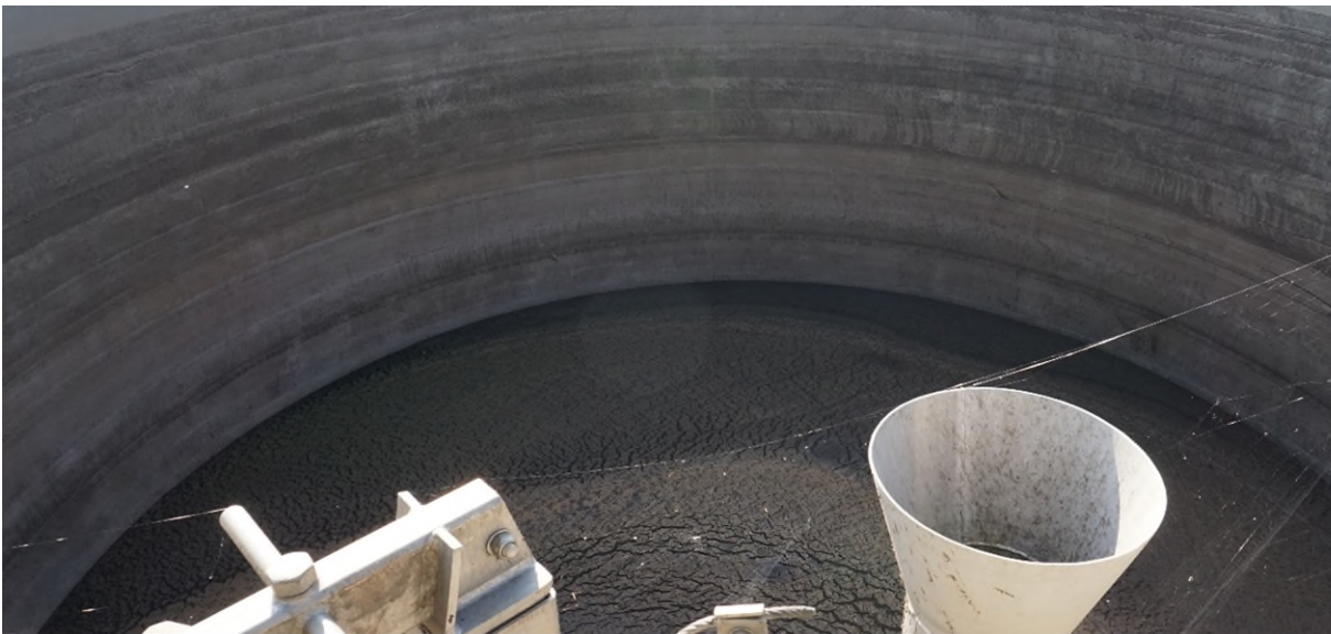
Abb. 7: Blick in einen teilgefüllten Schlammstapelbehälter
