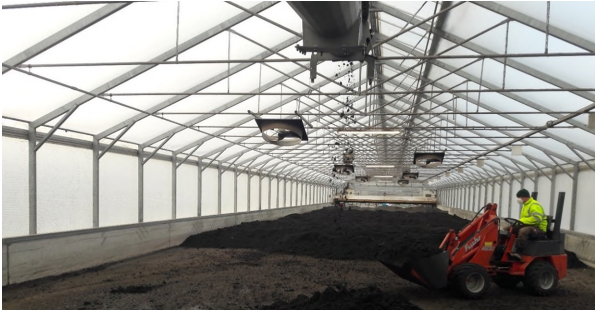
Abb. 11: Solare Klärschlamm-trocknung in einer Halle
