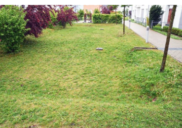
Abb. 16: Eine dezentrale Versickerungsfläche dient der Einleitung von Niederschlagswasser von Gehwegen und Dachflächen.
