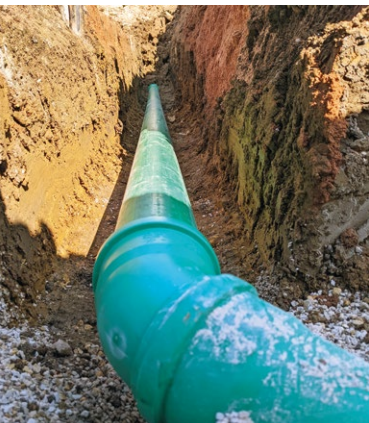
Abb. 6: Bau einer Grundstücksentwässerungsleitung
