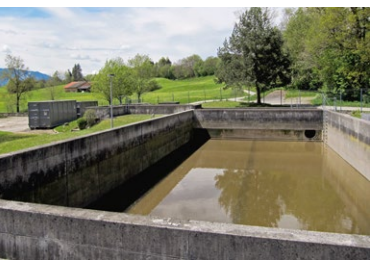
Abb. 18: Entlastungsbauwerk auf der Kläranlage
