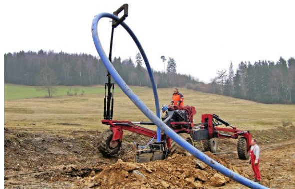
Abb. 19: Einpflügen einer Verbundleitung
