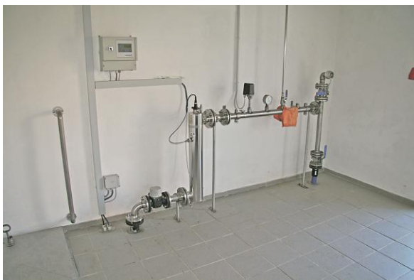
Abb. 18: Desinfektionsanlage
