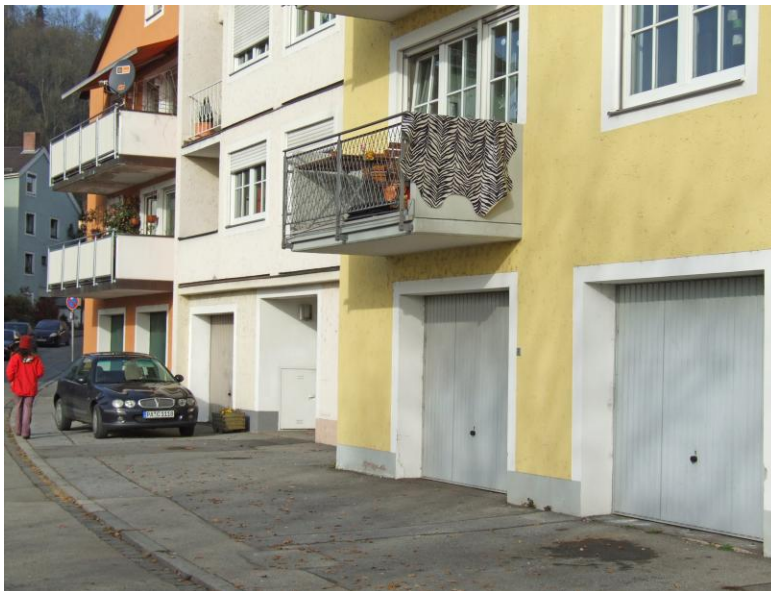
Abb. 80: Untergeordnete Nutzung im Erdgeschoss (überflutungsgefährdeter Bereich)
