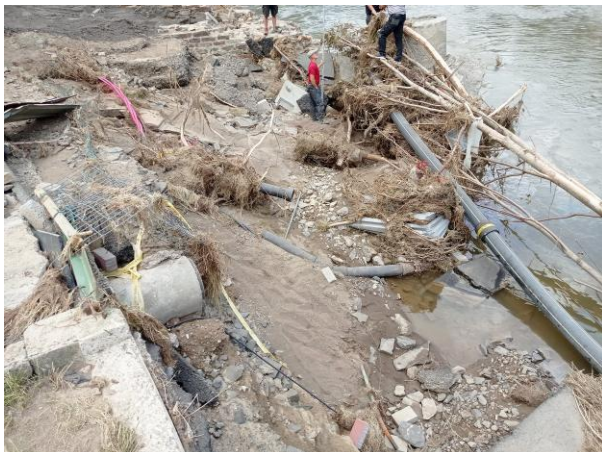
Abb. 8: Zerstörte Infrastruktur im Innenstadtbereich in Bad Neuenahr-Ahrweiler
