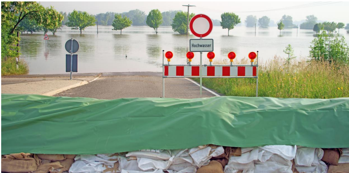
Abb. 77: Hochwasser mit Sandsackbarriere
