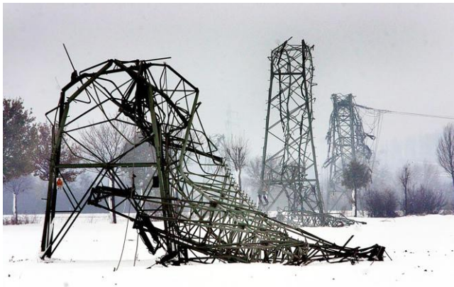
Abb. 3: Abgeknickte Strommasten im Münsterland
