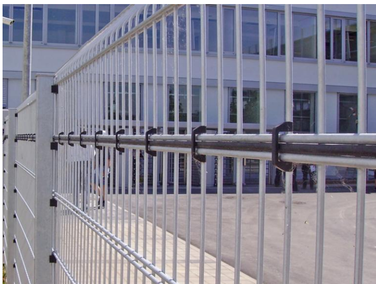
Abb. 84: Zaun mit elektronischer Überwachung
