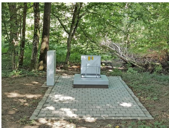
Abb. 33: Abschließbarer Brunneneinstiegsschacht
