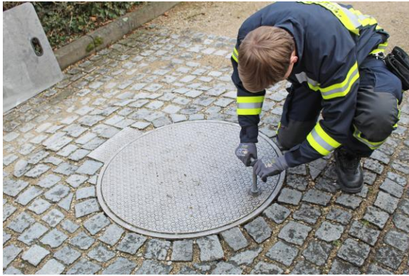
Abb. 49: Übung der Feuerwehr Augsburg für den „Aufbau einer Ersatzwasserversorgung“ – Öffnung des Notbrunnens
