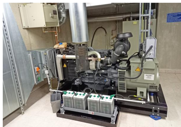
Abb. 27: Stationäre Netzersatzanlage
