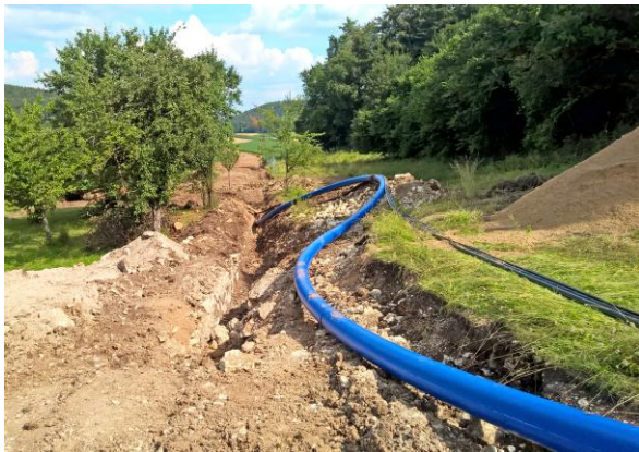
Abb. 92: Bau einer Verbundleitung
