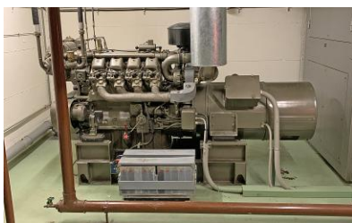
Abb. 69: Stationäre Dieselnetersatzanlage
