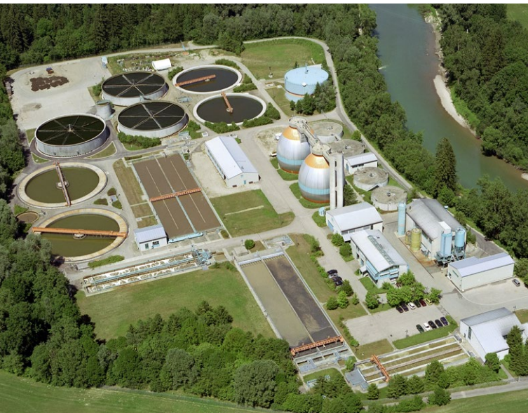
Kläranlage im Auenbereich
