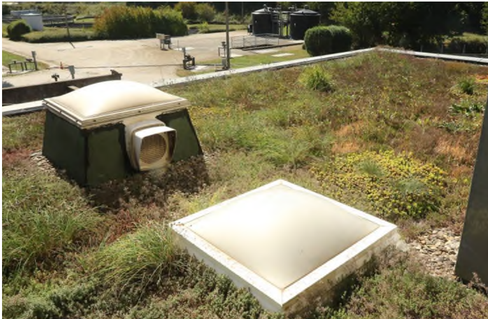
Abb. 14: Extensiv begrünte Flachdächer bieten öko- logische und auch wirt- schaftliche Vorteile.
