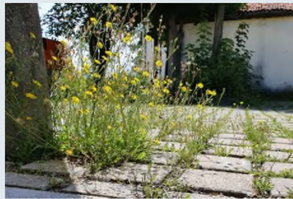
Parkflächen mit offenen Fugen
