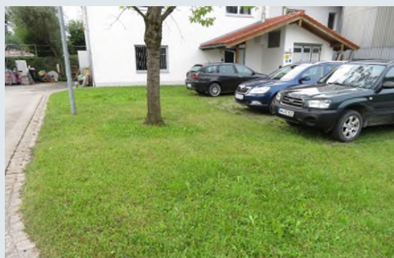
Befestigung der Parkplätze mit Rasengittersteinen
