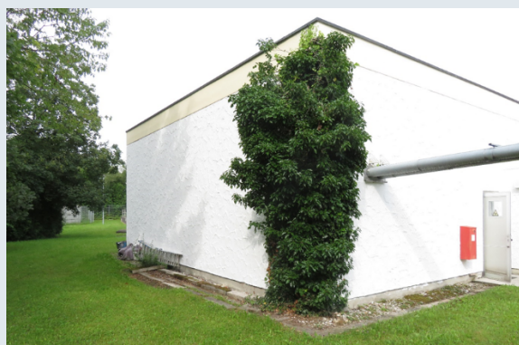
Vorhandene Fassadenbegrünung, für die noch eine zusätzliche Rankhilfe angebracht werden soll
