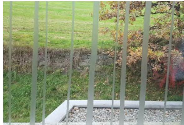
Abb. 18: Das fachgerechte Aufbringen von Vogelschutzmustern kann verhindern, dass Vögel mit Fensterscheiben kollidieren. Geprüfte Muster finden sich unter www.wua-wien.at .
