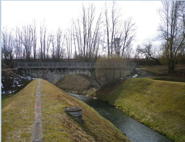
Abb. 4-19: Blick in Fließrichtung des Simbachs auf die Brücke im März 2013
