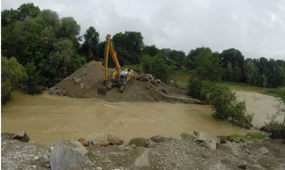
Abb. 4-12: Polderentleerung durch Dammbresche zum Inn
