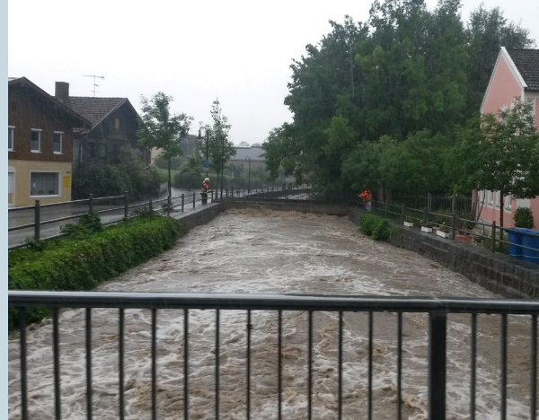
Abb. 4-14: Abfluss im Simbach (Bachstraße) am 1. Juni 2016 etwa eine Stunde vor der Spitze der Hochwasserwelle. Der Freibord beträgt circa 50 Zentimeter.
