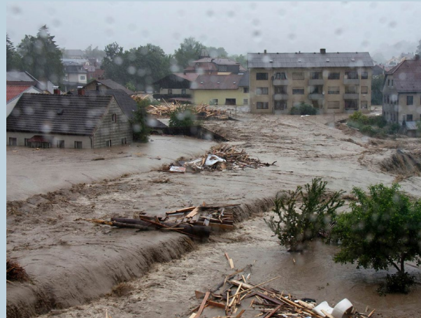
Abb. 4-20: Das Wasser überströmt den orografisch rechten (westlichen) und linken (östlichen) Deich (Blick gegen Fließrichtung).
