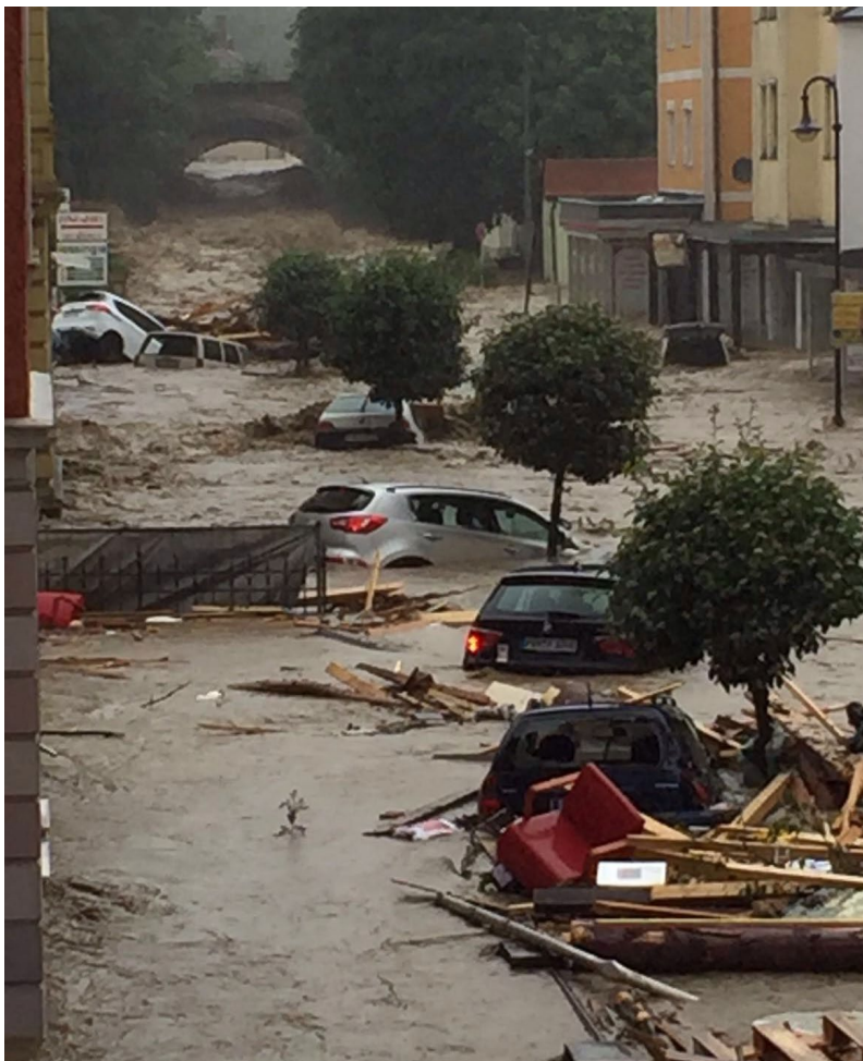
Abb. 3-7: Der Simbach hat sich am 1. Juni 2016 einen neuen Weg über die Innstraße in Simbach am Inn gesucht.
