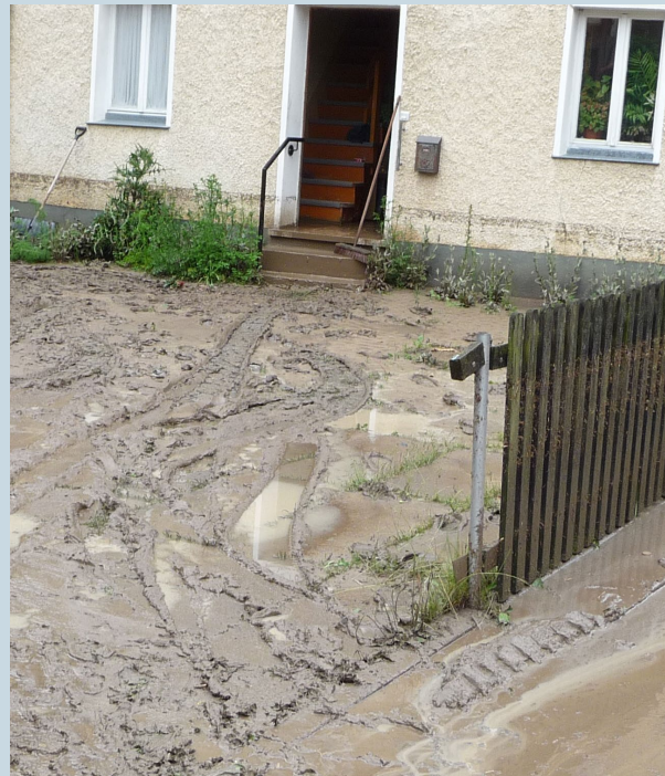
Abb. 4-5: Schlammablagerungen in Oberzenn
