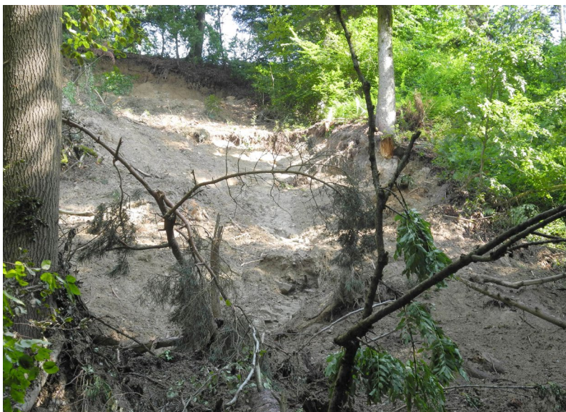
Abb. 3-11: Rutschung im Einzugsgebiet des Simbachs
