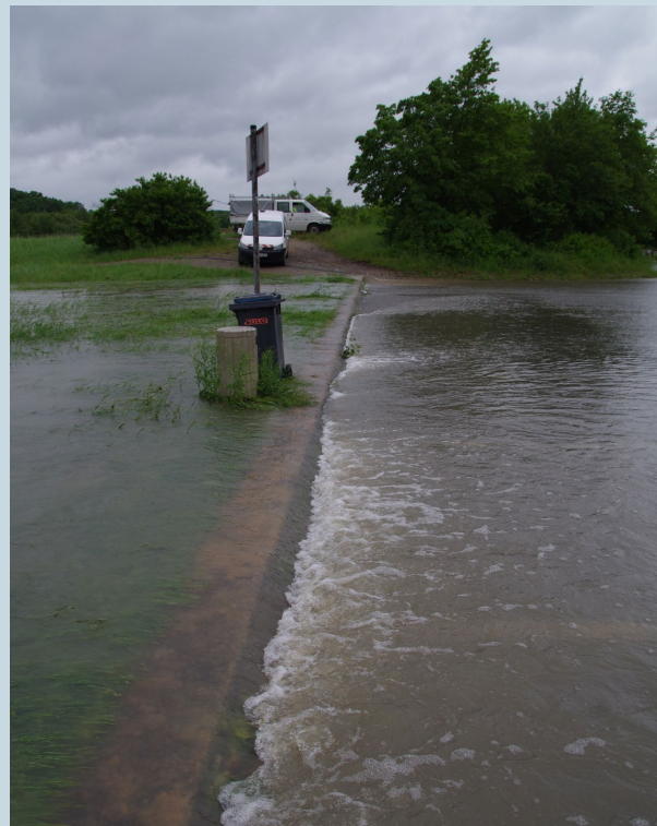
Abb. 4-7: Überströmte Hochwasserentlastungsanlage
