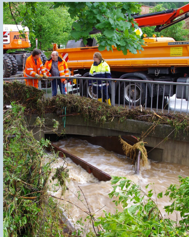
Abb. 4-3 (unten): Bauschuttcontainer in einem Brückenquerschnitt im Ortsteil Sondernohe. Der Bauschuttcontainer wurde durch das Wasser in den Brückenquerschnitt gedrückt und konnte erst mit schwerem Gerät wieder herausgezogen werden.
