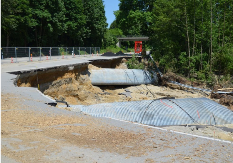
Abb. 3-21: Freigelegte Wellstahldurchlässe an der Anschlussstelle B 12/St 2112
