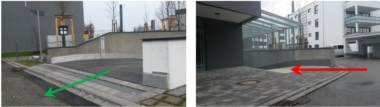
Abb. 6-4: Mit einfachen Mitteln lassen sich im Rahmen der Bauvorsorge Risiken wirkungsvoll reduzieren. Beispielsweise kann bei Tiefgarageneinfahrten mit einer Schwelle weitgehend verhindert werden, dass Oberflächenwasser von der Straße aus eindringen kann (links). Im anderen Fall besteht die Gefahr, dass schon bei geringen Wasserständen auf der Straße Wasser in die Tiefgarage läuft (rechts).
