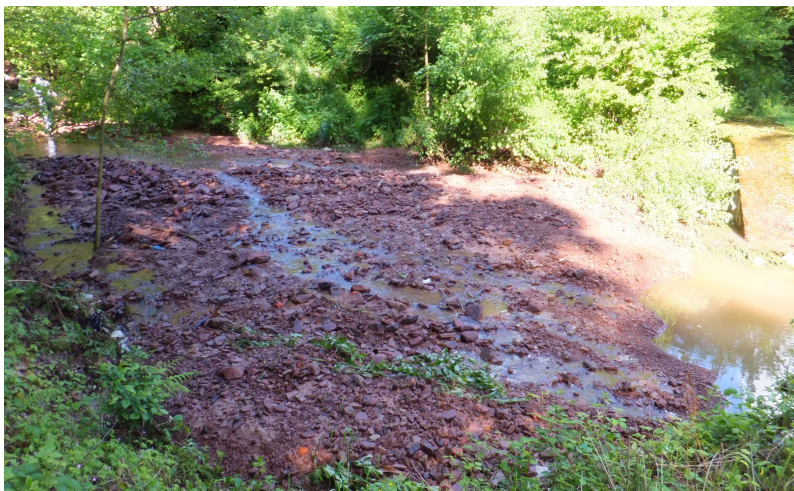
Abb. 5-4: Vollgefüllte Geschieberückhaltesperre nach dem Ereignis am 29. und 30. Mai 2016 am Wildbach, Gemeinde Eichenbühl, Landkreis Miltenberg
