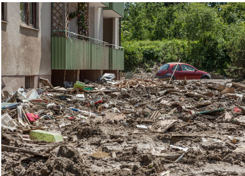
Abb. 3-13: Simbach am Inn: Schlamm und Dreck bleiben zurück, wenn das Wasser fort ist.
