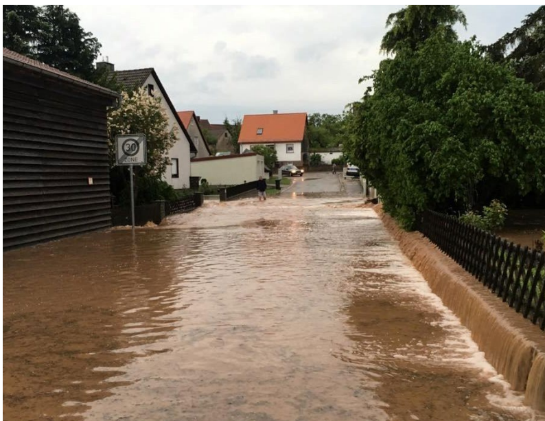
Abb. 3-6: Wild abfließendes Wasser überströmt die Schulstraße im Ortsbereich von Flachlanden, Landkreis Ansbach.
