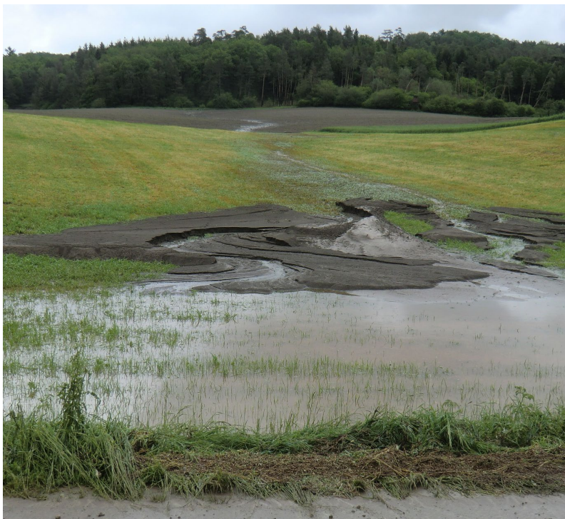
Abb. 3-8 (links): Erosion feiner Bodenpartikel im Bereich Oberdachstetten, Landkreis Ansbach;
