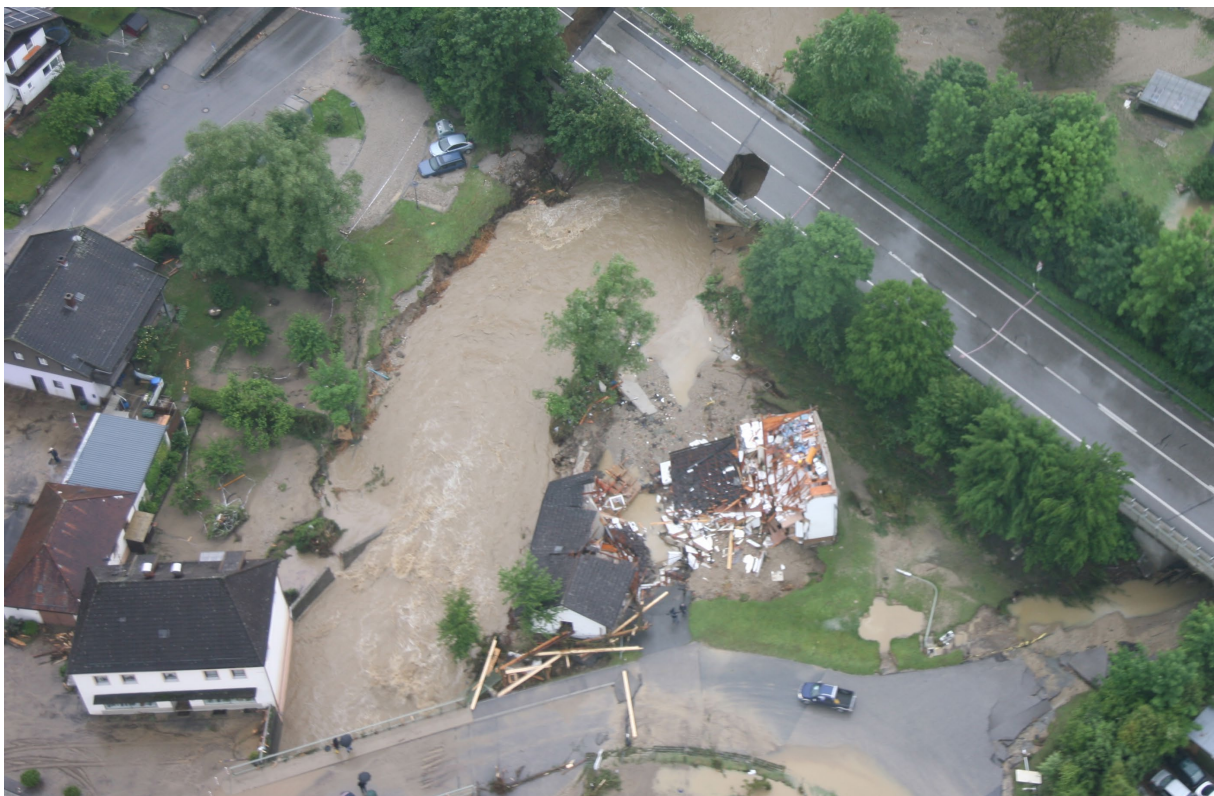
Abb. 3-17: Zerstörtes Haus in Julbach im Landkreis Rottal-Inn
