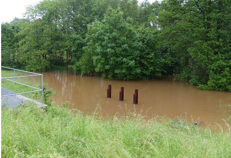
Abb. 5-2: Hochwasserrückhaltebecken am Erlenbach, Markt Jettingen-Scheppach, Landkreis Günzburg
