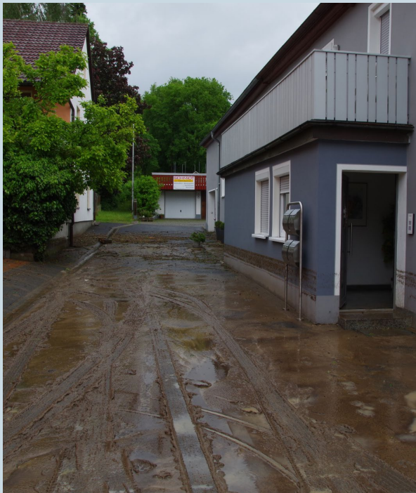
Abb. 4-4: Schäden an Wohngebäuden in Oberzenn, Wasserstand circa 80 Zentimeter
