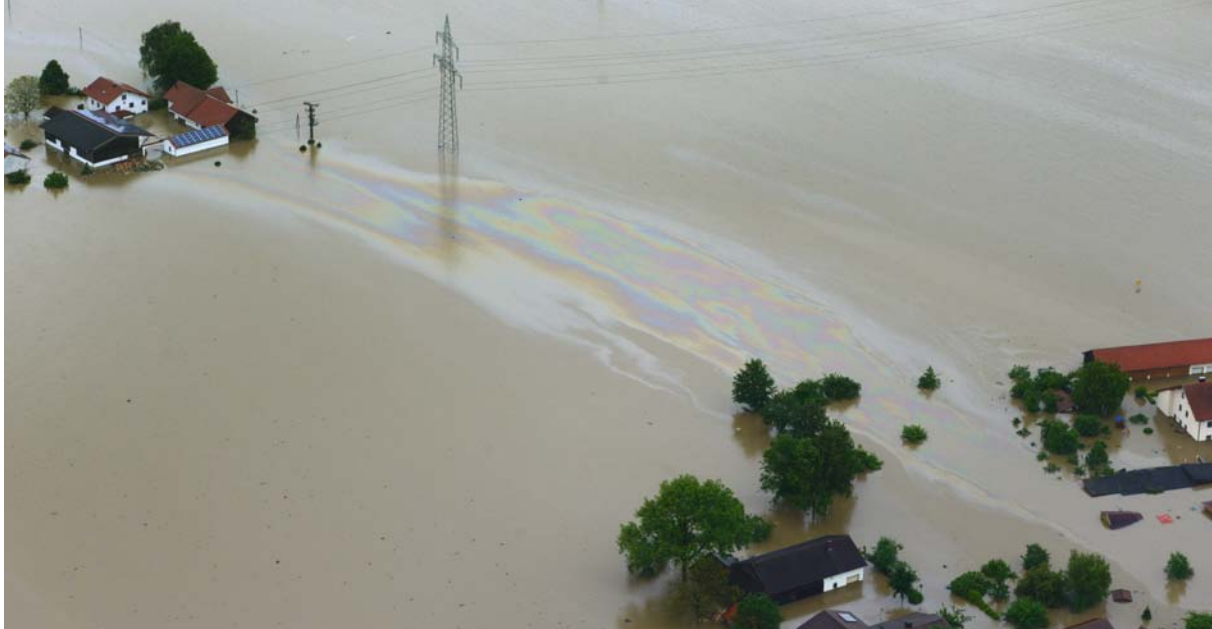
Abb. 7-1: Durch das Hochwasser verursachter Ölschaden
