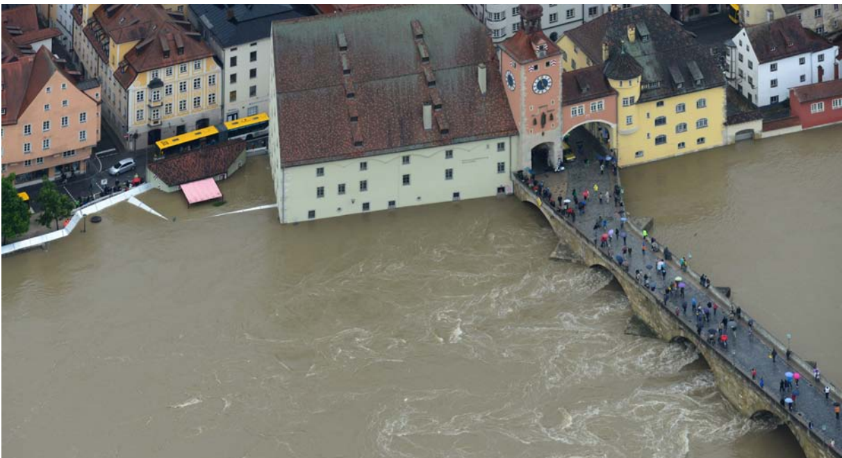
Abb. 4-2: Regensburg, Einsatz der Notfallsysteme
