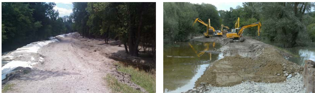
Abb. 4-4: Deichbruch Isar, Bau eines Notdeiches zum Schutz vor der zweiten Hochwasserwelle
