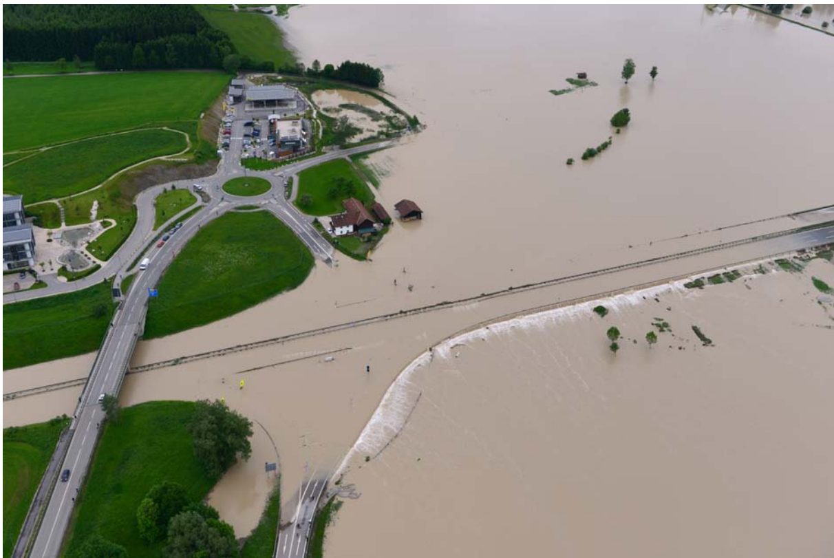
Abb. 4-9: Überflutung der Bundesautobahn A8, Anschlussstelle Grabenstätt
