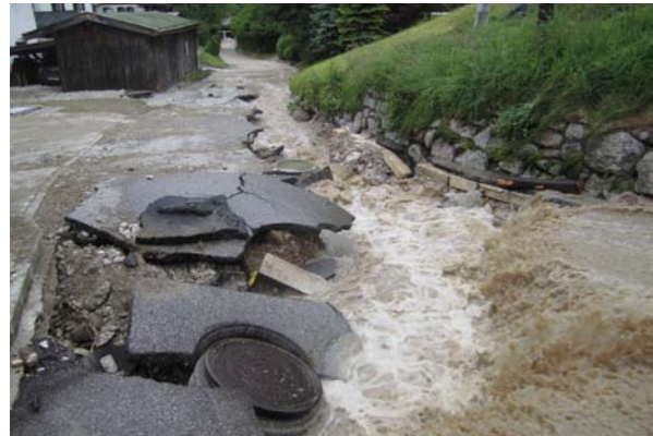
Abb. 5-5: verlegte Verrohrung am Bergbach
