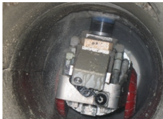
Abb. 25 (rechts): Roboter beim Spachteln
