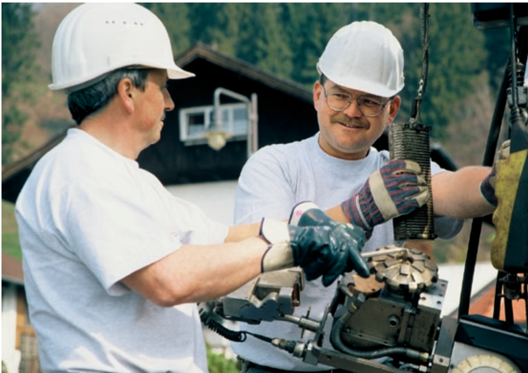
Abb. 12: Fräsroboter vor dem Einsatz im Kanal
