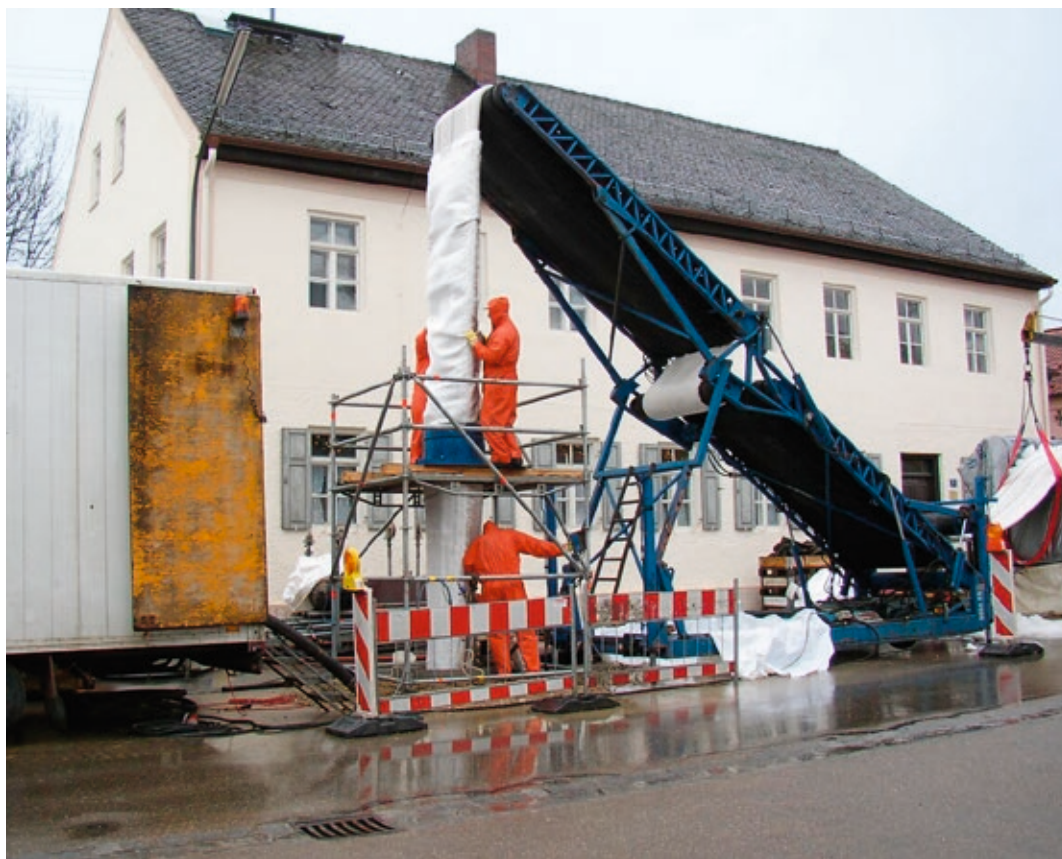
Abb. 26: Einbau des Schlauchliners über den Schacht in den Kanal
