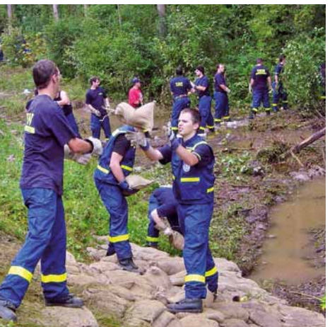
Augusthochwasser 2005: Einsatzkräfte – hier das Technische Hilfswerk – sichern einen Deich.
