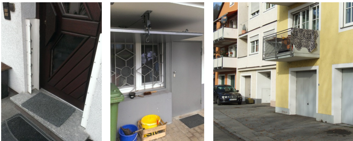
Abb. 6: Einfache Maßnahmen können große Schäden vermeiden: Halterung für ein mobiles Barriersystem (links), Fensterklappe (Mitte), hochwasserangepasstes Bauen in der Passauer Ilzstadt (rechts).
