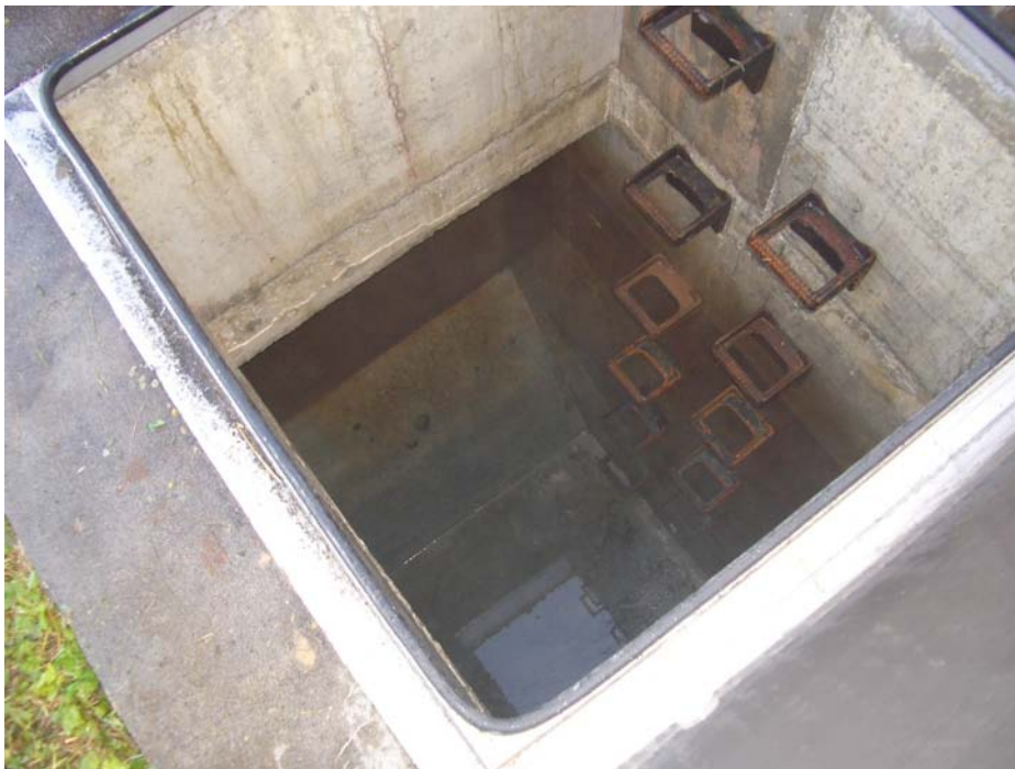
Abb. 19: Entleertes Absetzbecken mit Schlammfang
