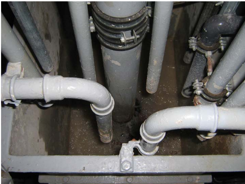
Abb. 11: Auslauf des Schlammwassers in einen Trichter
