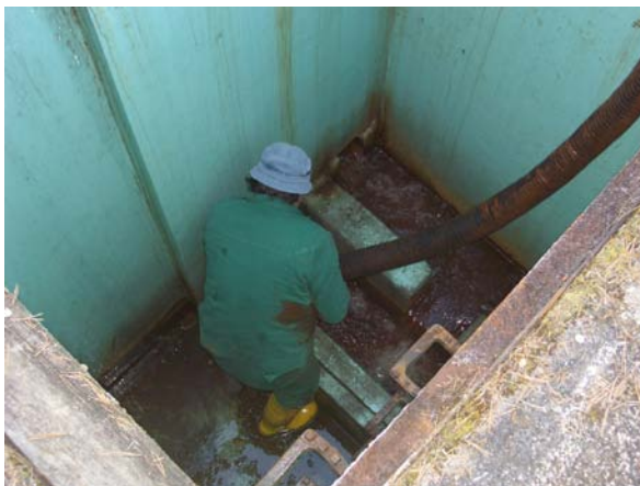
Abb. 34: Reinigung des Absetzbeckens
