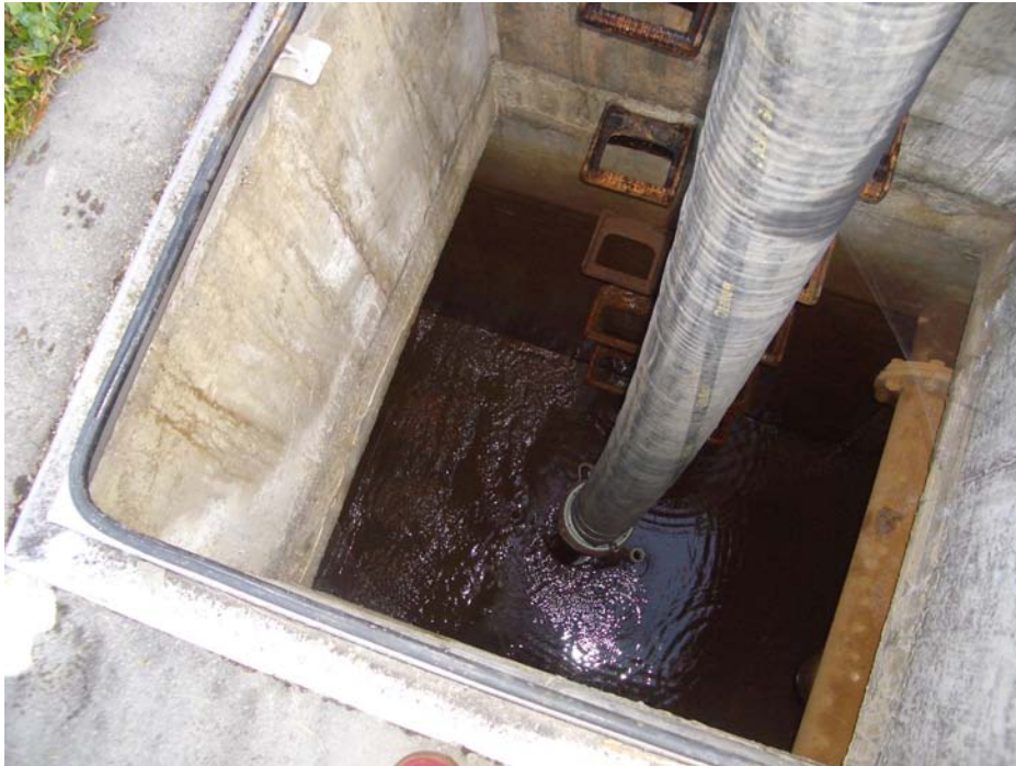
Abb. 23: Entleerung des Absetzbeckens
