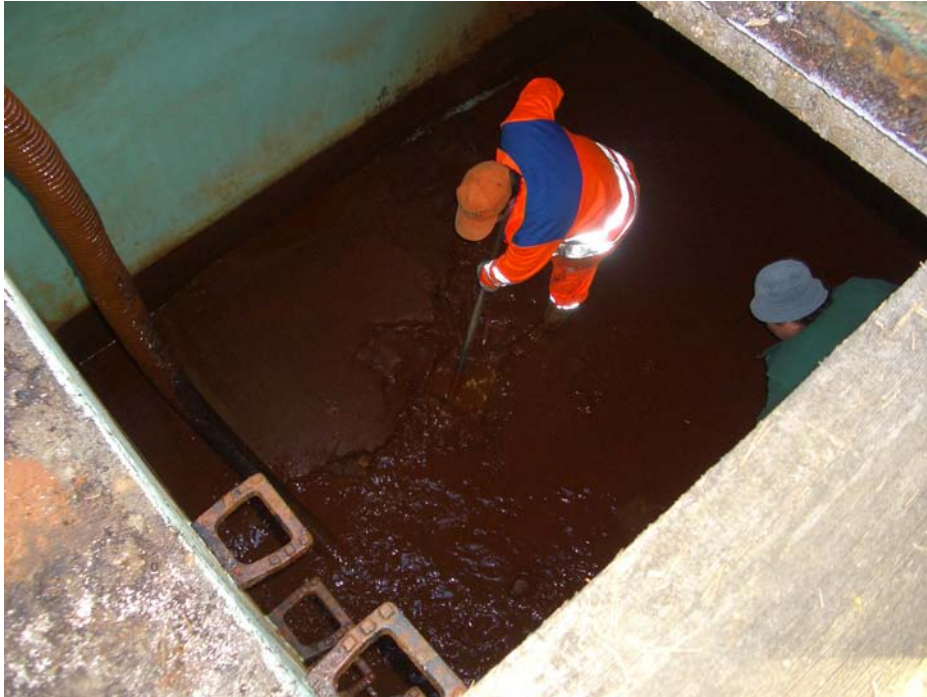
Abb. 33: Entleerung und Reinigung eines Absetzbeckens ohne trichterförmigem Schlammfang
