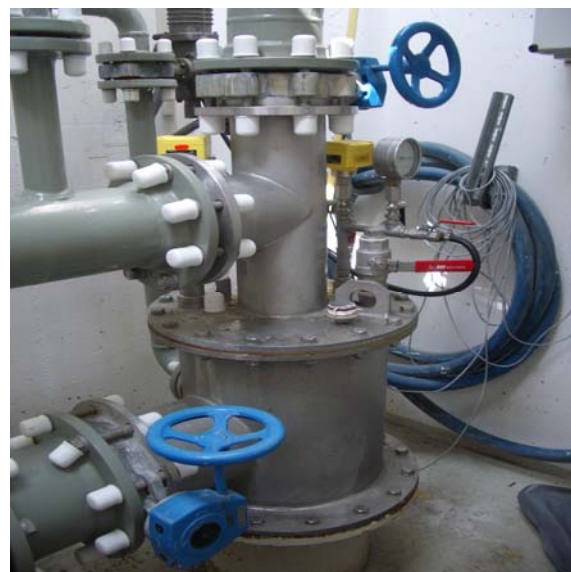
Abb. 8: Rohwasser aus Brunnen
