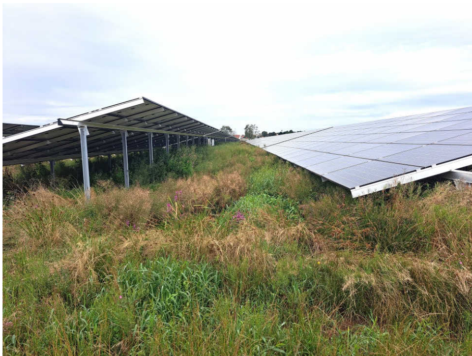
Abb. 42: Brachfläche im zentra- len Bereich des Ab- schnitts Schornhof I im Südteil der PV-Anlage am 28.07.2023
