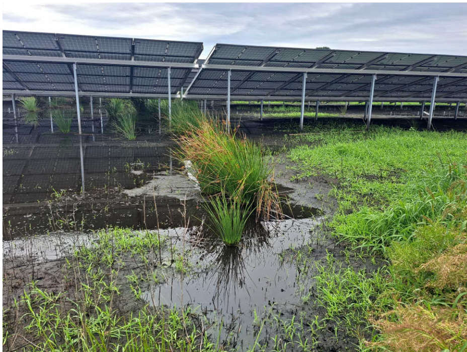
Abb. 32: Überstaute Modulflächen im Nordteil der PV-Anlage mit Nachweisen durchziehender Bekassinen und rufenden Grünfröschen
