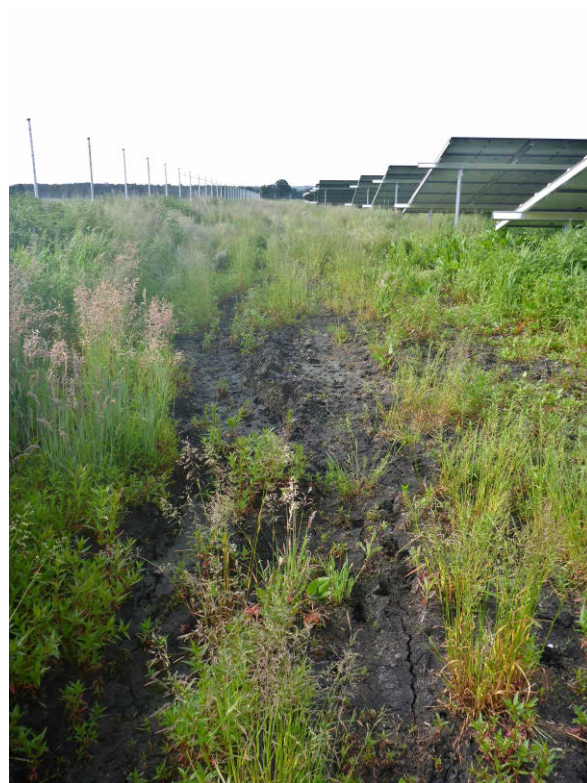
Abb. 34: Trockengefallene Pfützen am 30.05.2023 im östlichen Randbereich des Nordteils der PV-Anlage
