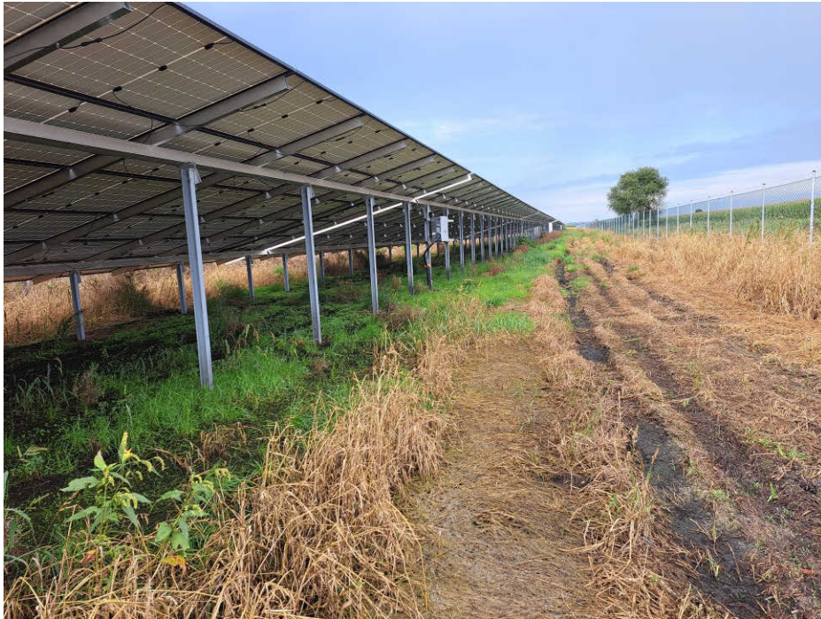
Abb. 43: Brachfläche mit nicht mehr wassergefüllten Fahrspuren am nördlichen Rand des Südteils der PV-Anlage am 13.09.2023.
