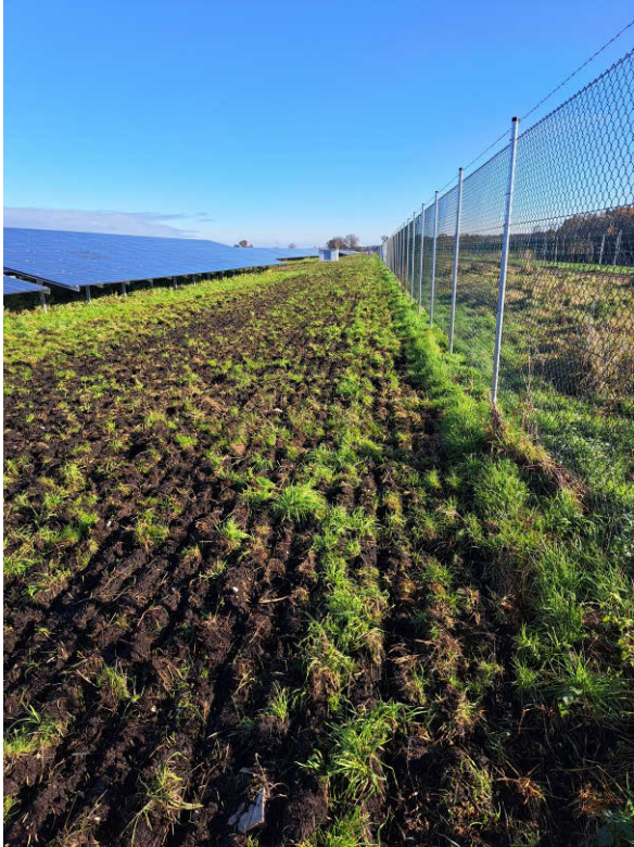
Abb. 47: Brachfläche im Randbereich einer umzäunten Modulfläche des Südteils der PV-Anlage mit einmaligem Rufnachweis einer Wachtel
