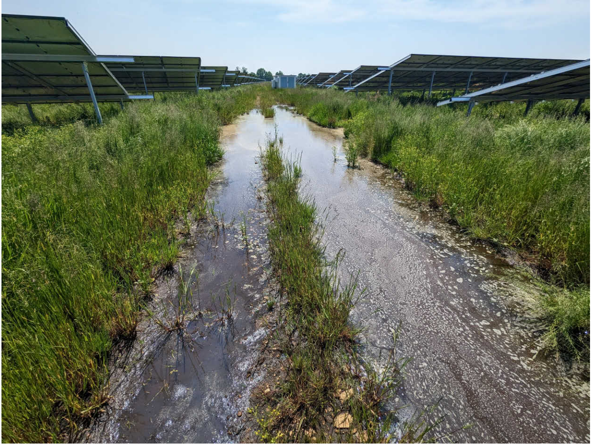
Abb. 5: PVA Schornhof, Teilfläche Schornhof I Süd. Zustand Mai 2023, Ausgedehnte Bereiche mit oberflächlichem Stauwasser nach dem niederschlagsreichen Frühjahr.
