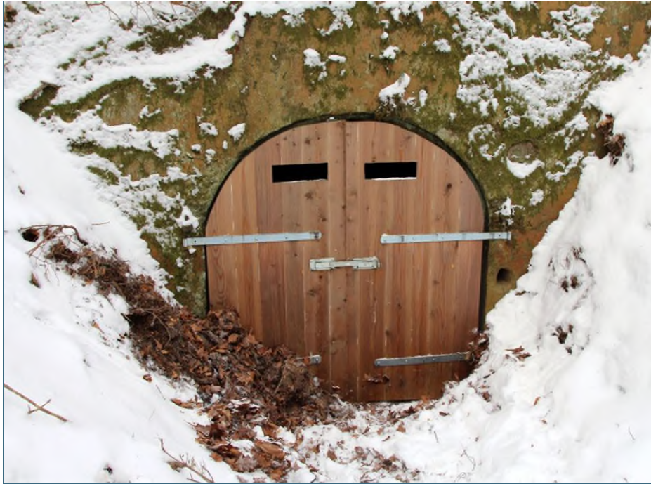
Abb. 28: Neue Holztür zur Sicherung eines Winterquartiers der Kleinen Hufeisennase im Landkreis Bayreuth (Foto: M. Hammer)
