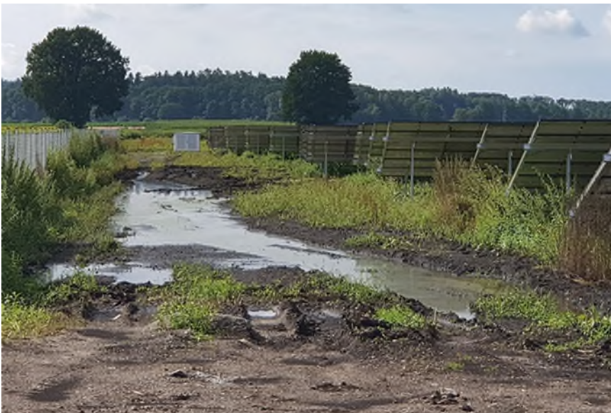
Abb. 23: 29.7.21, Ostrand des Nord- teils, Blick nach Süden; Fahrspuren mit temporären Pflützen
