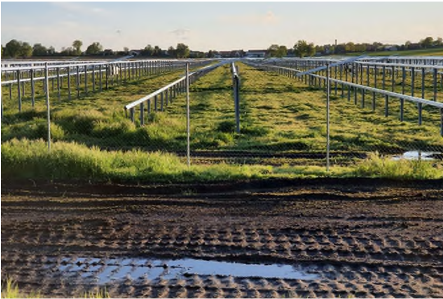
Abb. 34: 23.5.21, Südteil, Blick nach Westen; Module noch nicht montiert
