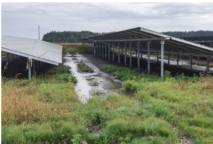
Abb. 27: 22.9.21, Nordteil, Blick nach Osten; Fläche zwischen Modulen mit wassergefüllten Fahr- spuren
