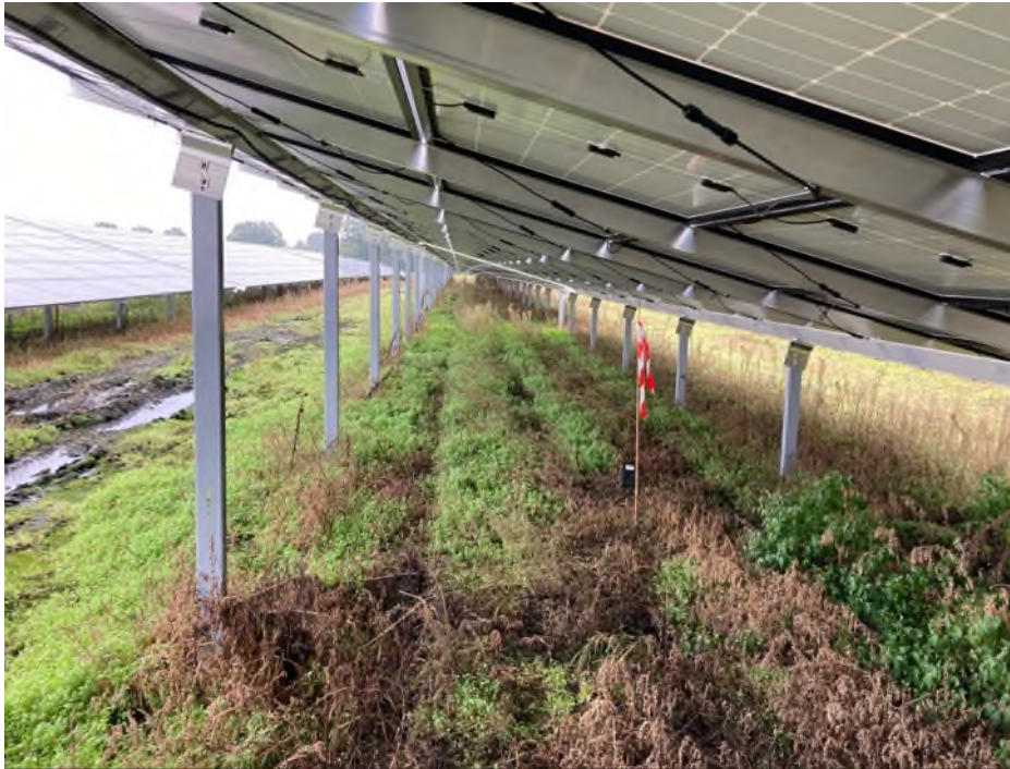
Abb. 13: PVA Schornhof, Teilfläche Süd, Kamerastandort H011 unter einem Solarpanel in niedriger, artenarmer Ruderalflur. Die Längs- rillen zeigen Boden- erosion in Folge des Wasserabflusses von den Solarpanelen dar. Beispiel für einen Kam- erastandort mit sehr niedriger Kleinsäuger- diversität
