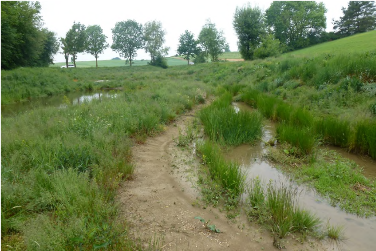
Abb. 33: Blick nach Westen – Zustand im Mai 2018 (Foto: Landratsamt Pfaffenhofen a. d. Ilm, untere Naturschutzbehörde)
