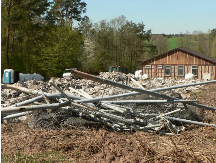
Abb. 10: Abrissarbeiten (Foto: Bundesforst)
