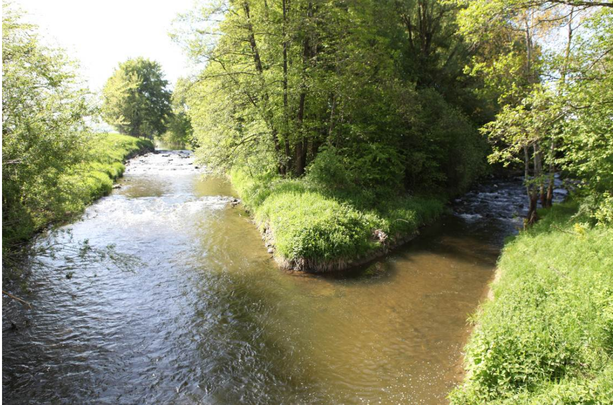
Abb. 3: Zusammenfluss von Mindel und Westernach (rechts) mit jeweils renaturierten Sohl-schwellen
