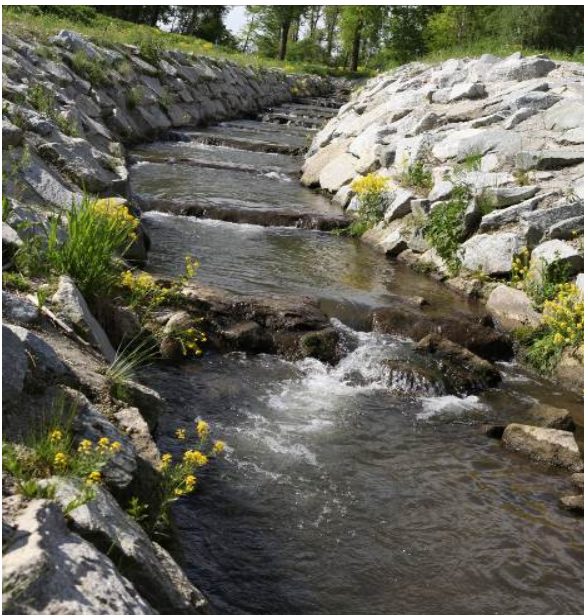
Abb. 5: Fischaufstiegsanlage an der Mindel unterhalb der Flossachmündung in Nahaufnahme und Überblick
