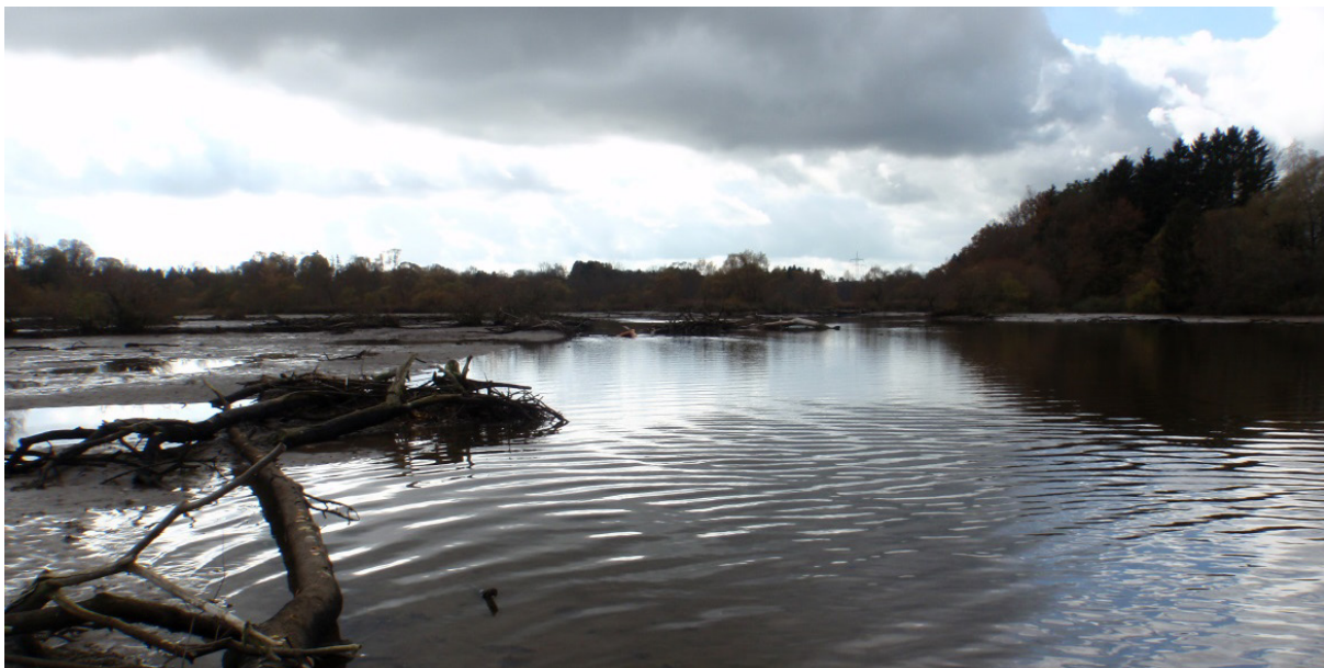
Abb. 15: Schlingener Stau mit Totholz bei Niedrigwasser bzw. abgesenktem Stau
