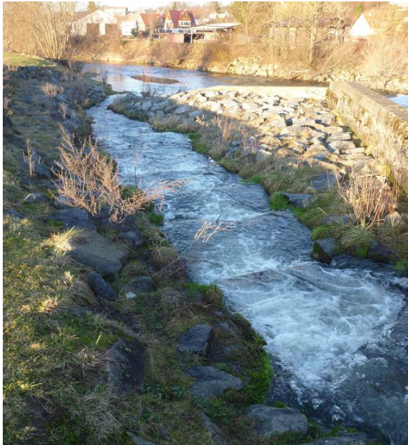
Abb. 6: Fischaufstiegsanlage an der Mindel bei Münsterhausen
