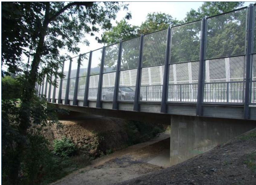
Abb. 5: Brücke über den Siechenbach im Stadtgebiet von Saalfeld mit beidseitigem 4 m hohem Kollisionsschutzzaun kurz nach der Inbetriebnahme (Foto: M. Biedermann, 2013).
