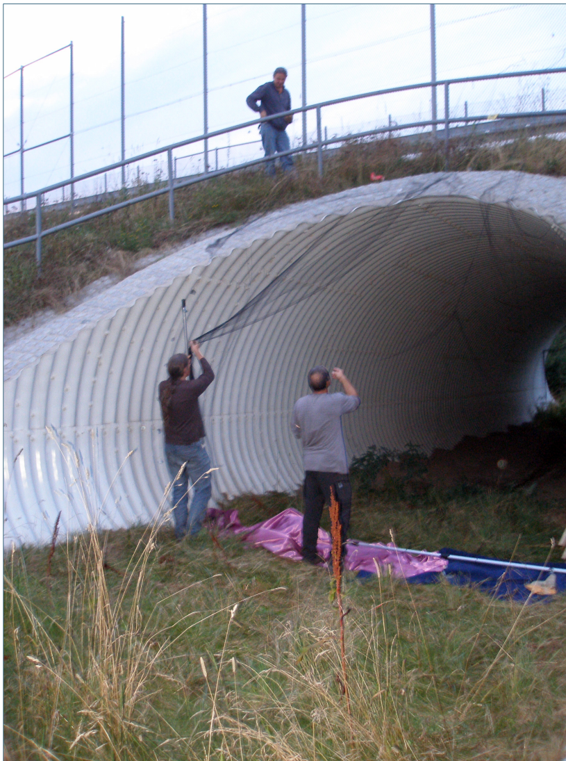
Abb. 12: Vorbereitung des Netzfanges am Hamco-Durchlass unter der S170n, der von der Nymphen- fledermaus genutzt wird. Dar- über befinden sich auf Fahr- bahnniveau beidseitig 4m hohe Schutzzäune. (Foto: K. Märki, 2013)
