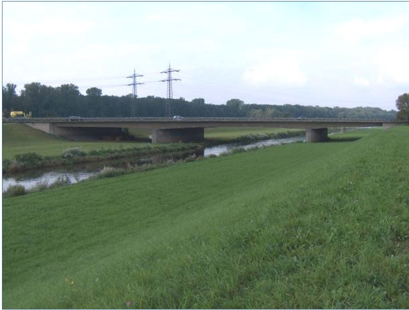
Abb. 1: Von der Nymphenfledermaus genutzter Durchlass der Kinzig mit beidseitigen Flutöffnungen und Dammbauwerken. Es ist nicht bekannt, welche konkreten Flugwege die Tiere zum Durchlass gewählt haben. Im Umfeld des Bauwerkes sind in der Fluss- aue Strukturen wie Waldränder, Baumreihen und Säume vorhanden bzw. bietet die Kinzig als Fließgewässer eine Leitstruktur (Foto: H. Schauer-Weisshahn, 2006).
