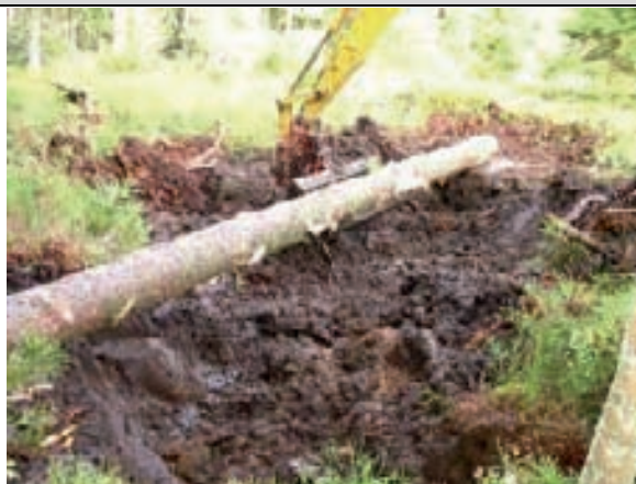
2. Einbau der Querlieger (Beginn)
