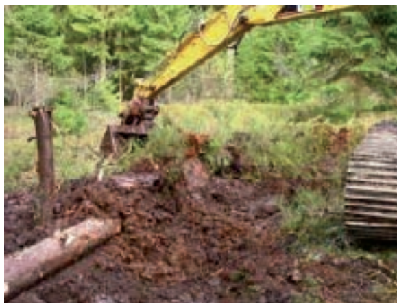
4. Einbau der weiteren Stammhölzer, gleichzeitig abschnittsweise Torfhinterfüllung, -Verdichtung, Sodenabdeckung
