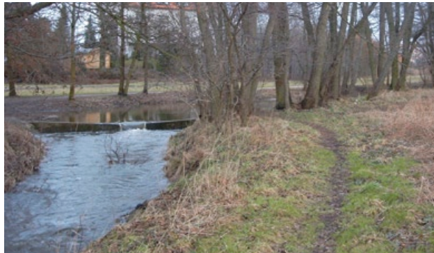
Abb. 61 (oben links): Sandfang vor der Renaturierung.
