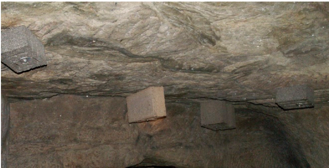
Abb. 36: Anbringen von Hohlblocksteinen im Fledermauskeller.
