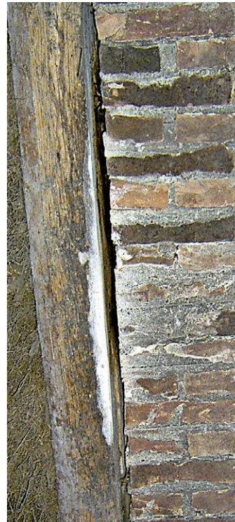
Abb. 29 (links): Graues Langohr in einer Mauerspalte einer unverputzten Wand.
