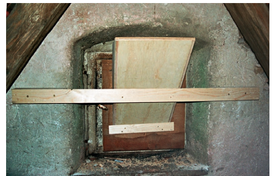
Abb. 51: Taubensicherer Durchflug für schmale Fensteröffnung im Querschnitt (links: Außenseite, rechts: Dachboden).
