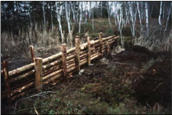
Foto 19. Fertiger Holzunterbau.
