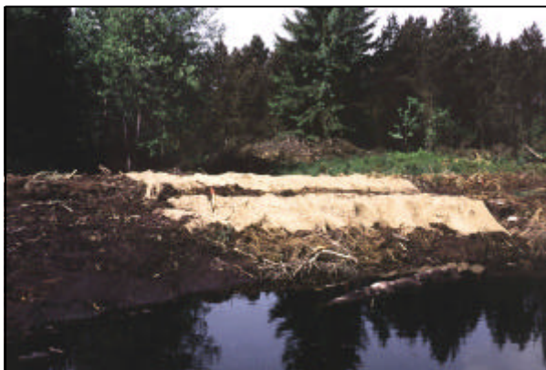
Foto 27. Fertiges Wehr aus massiven Holzspundwänden im Graben; hell: Jutenetz zur Sicherung des Torfes vor Erosion.
