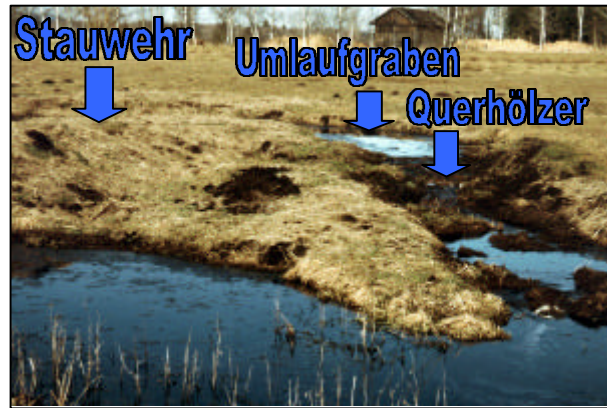
Foto 30. Umlaufgraben mit quer eingebauten Fichtenrundhölzern (Pfeil) zur Sohlsicherung.
