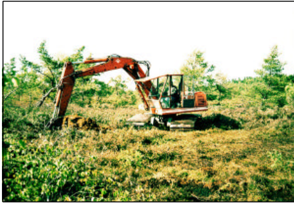
Foto 3. Vollständige Grabenverfüllung mit Torf durch Bagger (Maßnahme 8.1.1; Schwarzes Moor, Rhön; 8/2000): Torfentnahme zur Grabenverfüllung im Umgriff
