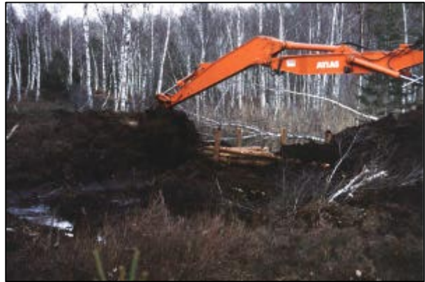
Foto 20. Torfverfüllung des Holzunterbaus. Foto 19/20 Röhrenbachfilze, Landkreis Garmisch-Partenkirchen; 12/2000.
