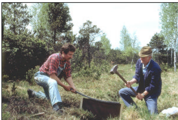
Foto 11. Maßnahme 8.1.3: Einbau von wasserfesten Holzverbundplatten.
