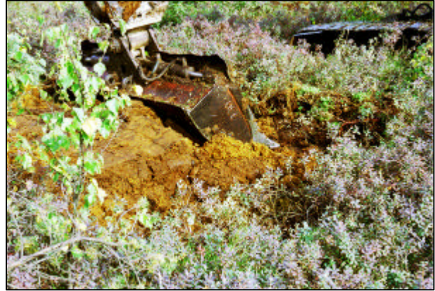
Foto 4. Eindrücken des Torfs zur Grabenverfüllung
