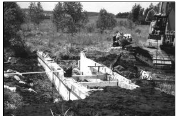
Foto 26. dto. – Ansicht der doppelreihigen Bauweise der massiven Nut- und Feder-Spundwände.
