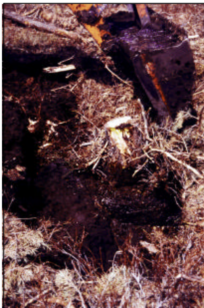
Foto 7. Maßnahme 8.1.2 Partielle Grabenverfüllung: Ausgraben der Grabensohle
