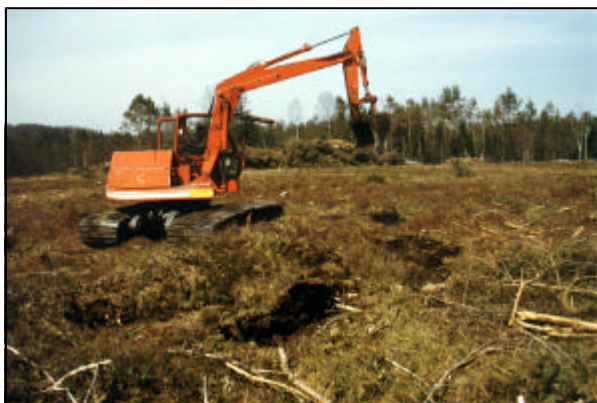
Foto 9. Maßnahme 8.1.2: Sodenabdeckung des Torfwalls zur partiellen Grabenverfüllung; Fotos 7-9: Moor östlich Eschenau, Lkrs. Rosenheim 4/2002
