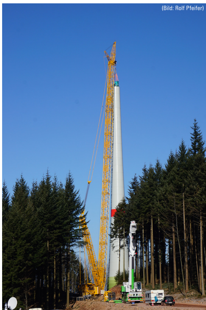
Abb. 2: Kran mit Kranausleger beim Bau einer Enercon E-115 Windenergieanlage.
