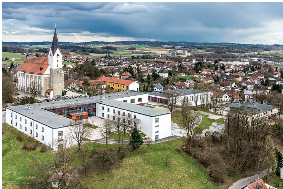
Schulgebäude der Mittelschule Hengersberg
