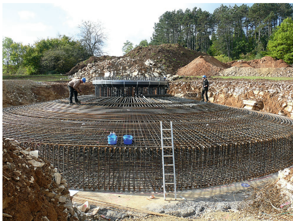
Errichtung des Fundaments
