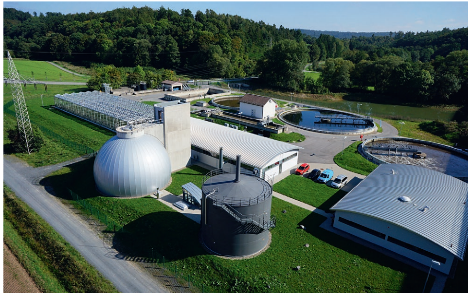
Gesamtansicht der Kläranlage
