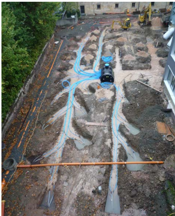
Abb. 3: Bauzustand Erdsonden- speicher
