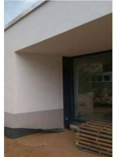
Abb. 19: Viatisschule – Außenansicht Dachüberstand
