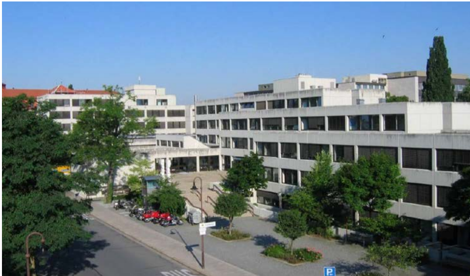
Abb. 1: Technisches Ämter- gebäude vor der Sanierung
