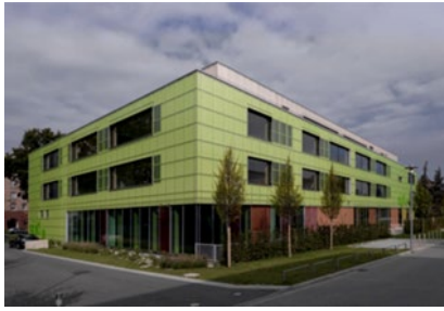
Abb. 6: südpunkt – Süd- / Ostfassaden
