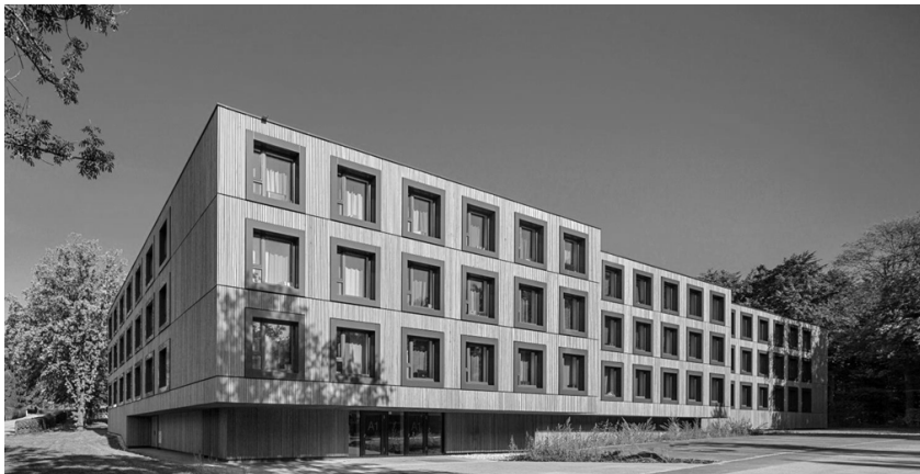
Abb. 23: Neubau des Unterkunftsgebäudes (Foto Michael Heinrich, München)
