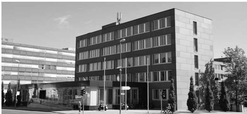
Abb. 25: Außenansicht des Verwaltungsgebäudes nach der Sanierung (Foto Staatliches Bauamt Bayreuth)
