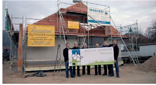
Wärmetauscher zur energetischen Nutzung von Abwasser in Straubing (links). Hebauf-Feier in Dollnstein (rechts)
