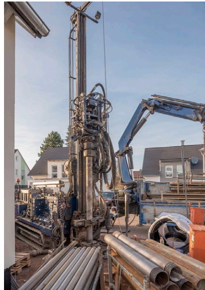
Erneuerbare Energien eignen sich gut zur Wärmeerzeugung: Biogasanlage (links oben), Solarthermieanlage (links unten), Geothermieanlage (rechts).
