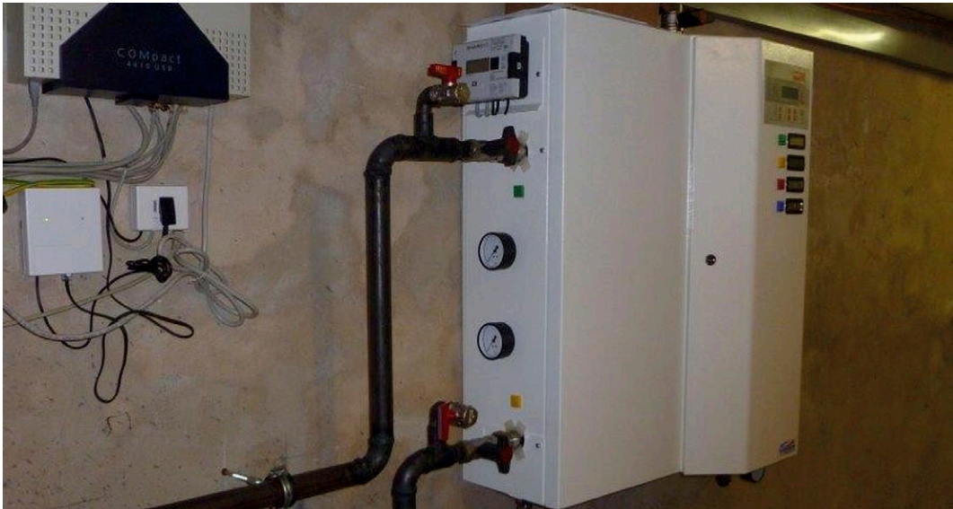
Eine typische Übergabestation für ein Ein- bis Zweifamilienhaus hat eine Größe von ca. 80 x 60 x 40 cm und eine Lebensdauer von etwa 30 Jahren.
