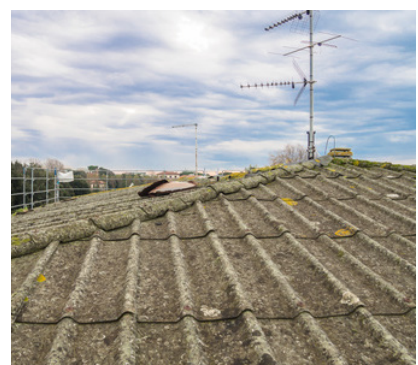
Abb. 10: und in Welldachplatten.
