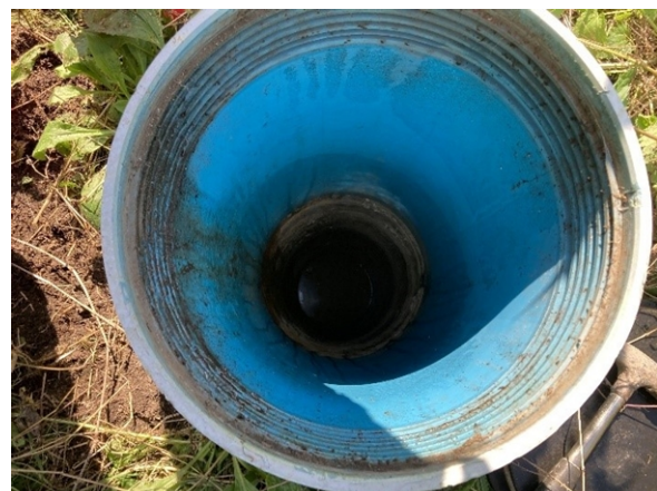
Abb. 12: Blick in Probenahmerohr Beweissicherungstrichter T16/T17.
