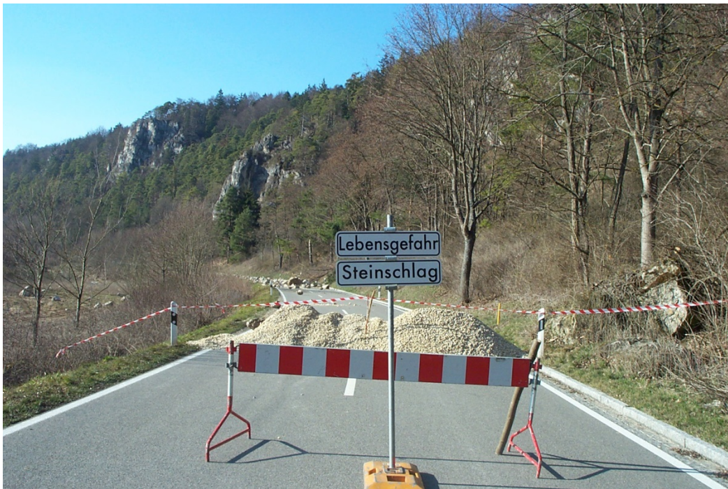
Akuter Felssturz im Altmühltal; eingewachsene Blöcke bezeugen frühere Ereignisse
