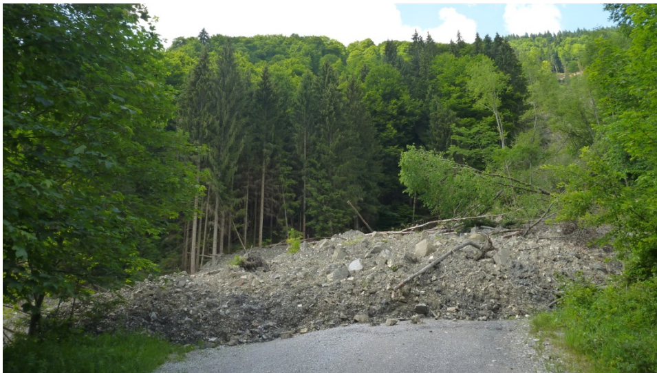
Abb. 22: Schuttstromablagerung unterhalb der Rutschung südlich Grafen- aschau Lkr. Garmisch- Partenkirchen). GEORISK Nr. 8332GR000017
