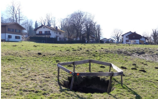
Abb. 7: Obwohl Erdfälle überwiegend klein sind, haben sie wegen ihrer meist spontanen Entstehung ein Gefährdungspotential.
