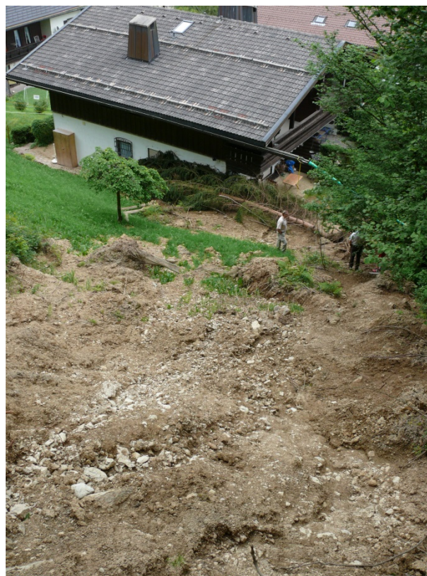
Abb. 6: Auch kleine Rutschungen, sogenannte Hangabbrüche, können große Schäden verursachen.
