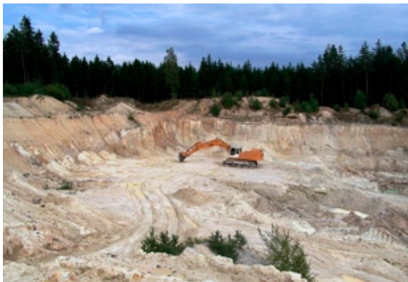
Abb. 4-2: Kaolinabbau auf der Gebhardtshöhe.
