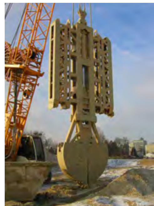
Der Einsatz von Spezialverfahren (Austauschbohrung links und Bau einer Reaktiven Wand rechts) stellt hohe Anforderungen an Technik und Personal.
