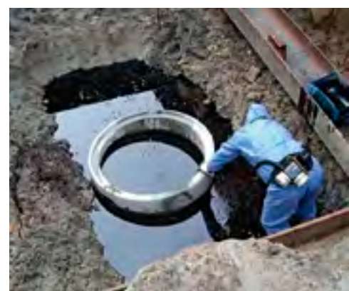
Sanierung eines Teerölschadens
