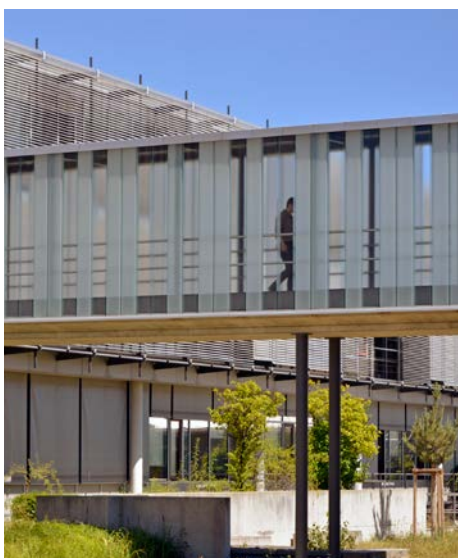
Abb. 22 (links): Ein Brennpunkt waren die verglasten Übergänge in den Innenhöfen.
