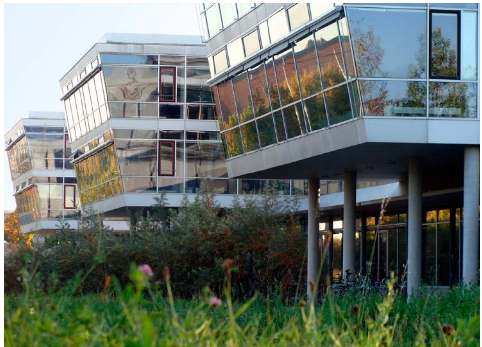
Abb. 21: Die Ostseite liegt quer zur Zugrichtung und spiegelt Bäume – eine echte Falle.
