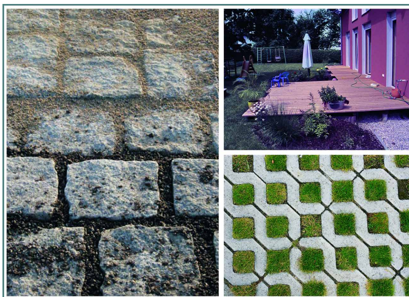
Abb. 5: Durchlässige Flächenbeläge sind z. B. Rasengittersteine (rechts unten) oder Steinpflaster mit Splittfugen (links) in Einfahrten. Auch Holzroste auf Terrassen (rechts oben) lassen Regenwasser versickern.
