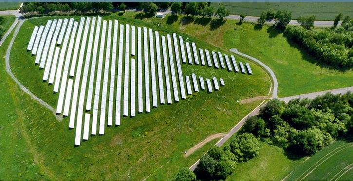
Abgeschlossene Deponie mit Photovoltaikanlage.
