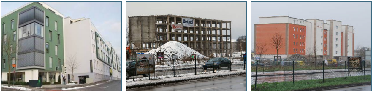
Abb. 8, 9, 10: Bei der Sanierung lässt sich nachhaltig Bauschutt vermeiden, wenn das alte Gebäude weitestgehend erhalten und modernisiert (Bild links) oder nur teilweise erhalten wird. Aus der bewahrten Stahlskelettstruktur eines Kasernenbaus (Bild Mitte) entstand ein modernes Heim für betreutes Wohnen (Bild rechts).
