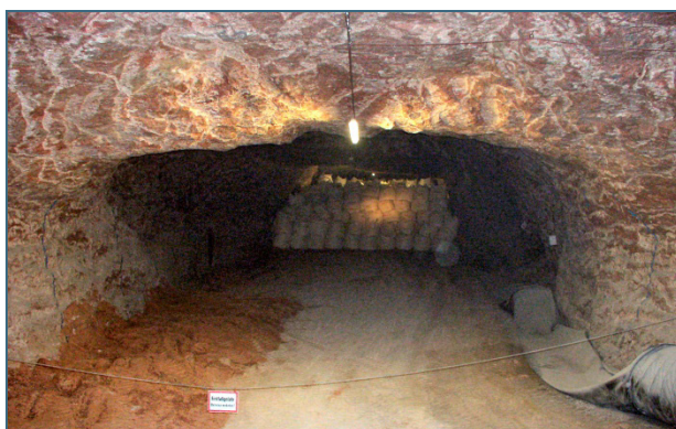
Abb. 28: Um Bergschäden zu vermeiden, nutzt man für den „Bergversatz“ nur standfeste Abfälle.
