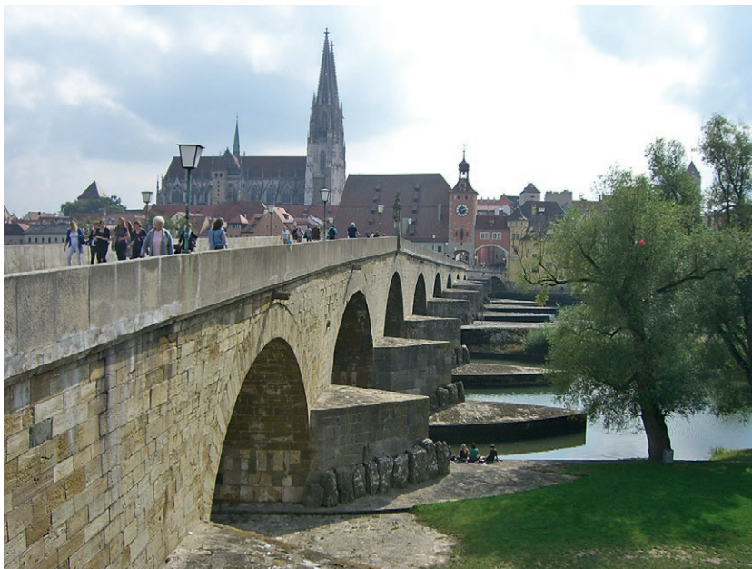
Abb. 1: Steinerne Brücke in Regensburg.
