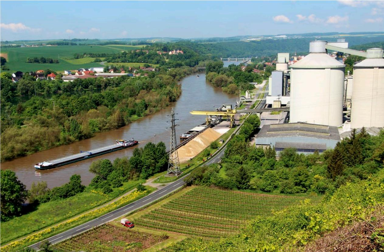
Die Kalksteine des Muschelkalks werden nicht nur zu Werksteinen und Schotter verarbeitet, sondern auch in der Zementherstellung verwendet. Die Nähe zum Main als Transportweg, wie hier bei Lengfurt, ist ein Standortvorteil.
