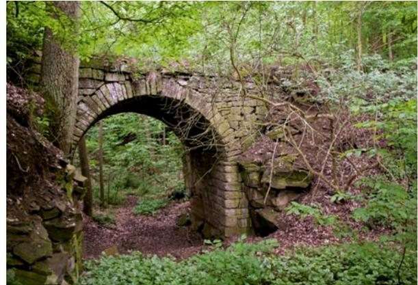
Die Steinbrüche südöstlich von Egenhausen liegen auf unterschiedlichen Niveaus. Eine Brücke aus Werksandstein ermöglicht den Zugang zum höher gelegenen Bruch.
