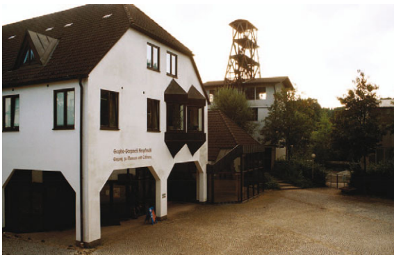
In Kropfmühl befindet sich das einzige Graphitbergwerk und Aufbereitung Deutschlands. Der Graphit wird zu mehr als 70 verschiedenen Graphitsorten verarbeitet.
