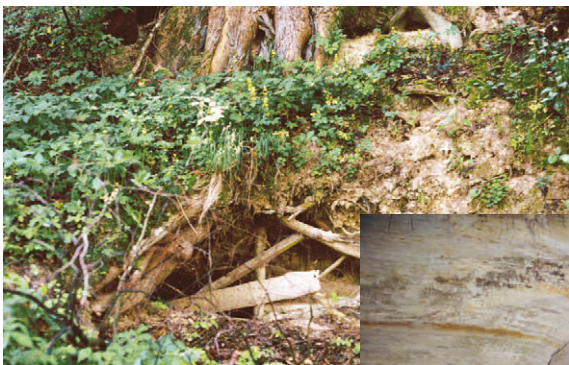
Verfallenes Stollenmundloch des ehemaligen Bergwerks Pranzmühle
