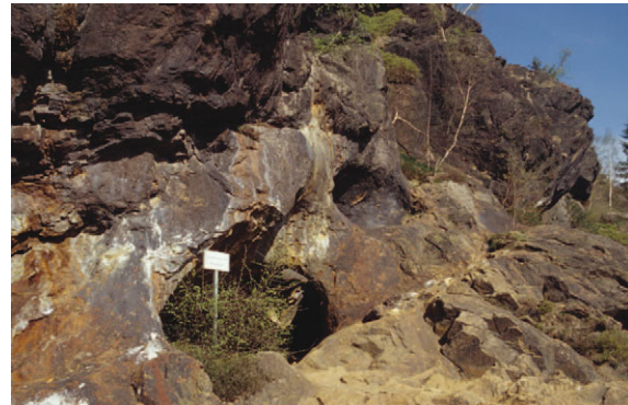
Die Vortriebsmethode des „Feuersetzens“ hinterließ typische rundliche Hohlraumformen.
