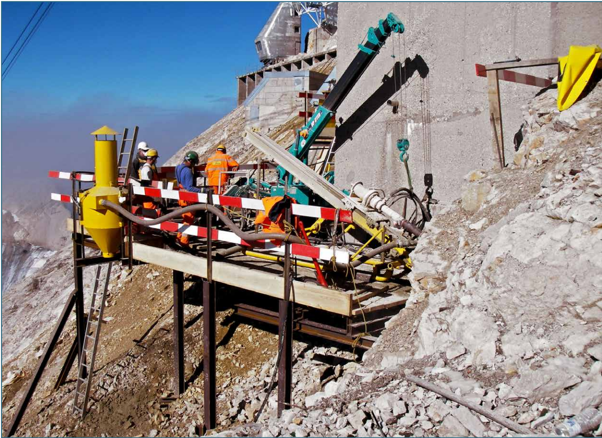
Abb. 3-7: Arbeitsplattform mit Bohrlafette, Minikran und Staubschutzfilter.
