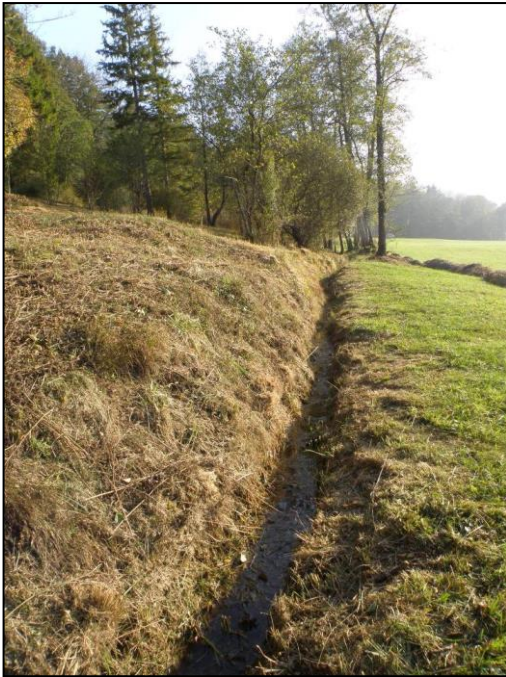
Abb. 3: Entwässerungsgraben entlang des Hangquellmoores (Foto: K. KALTENBACHER)
