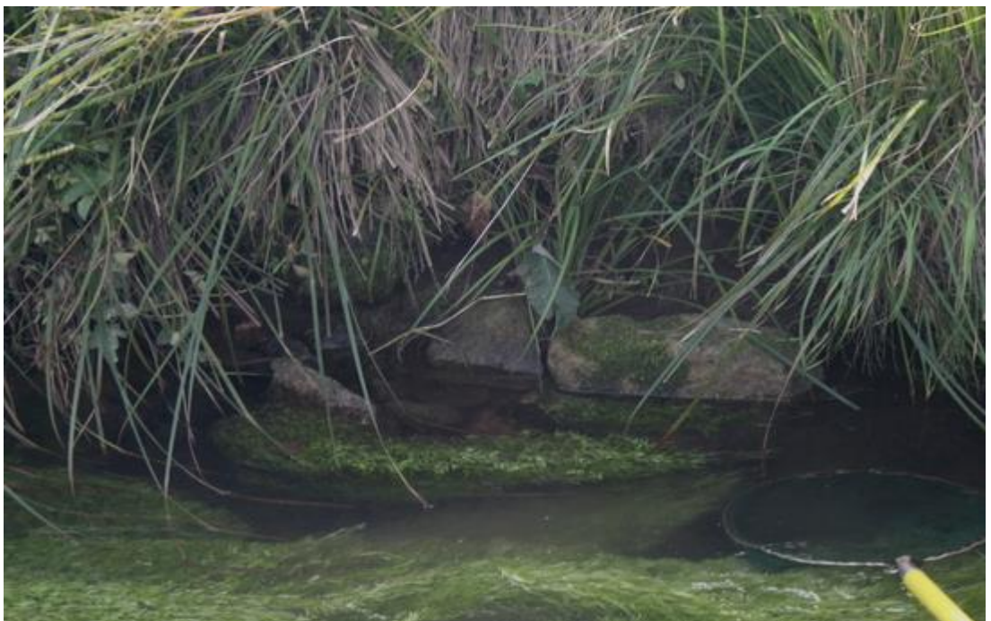
Abb. 8: Ufer- und Sohlenbefestigung am Loisbach (Foto: Ring, 13.09.2011)
