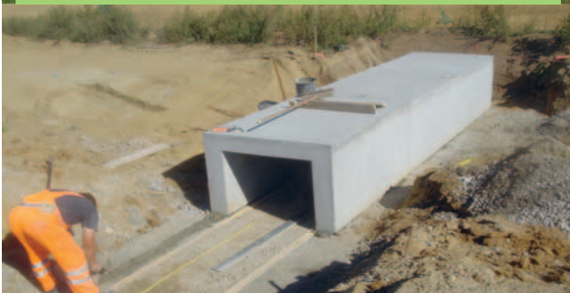
Installation eines Durchlasses zur Vermeidung von Barrierewirkungen und Individuenverlusten
