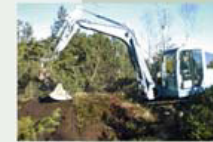
Mit einem Spezialbagger werden Mooren oder Moorenreste mit Grünem Moortorf verfüllt – ein wesentlicher Schritt zur Renaturierung und Wiedervermässung.
